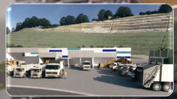
Oficinas de Manutenção
