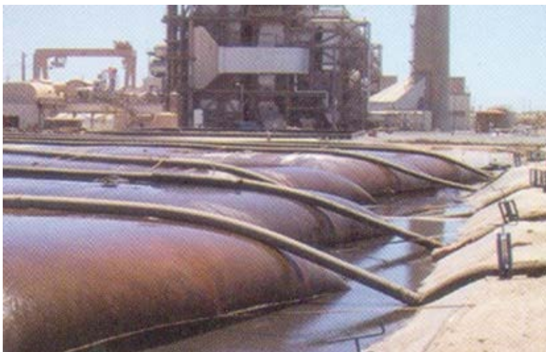
FIGURA 17.7 Desaguamento de lodos em tubos de geotextil
