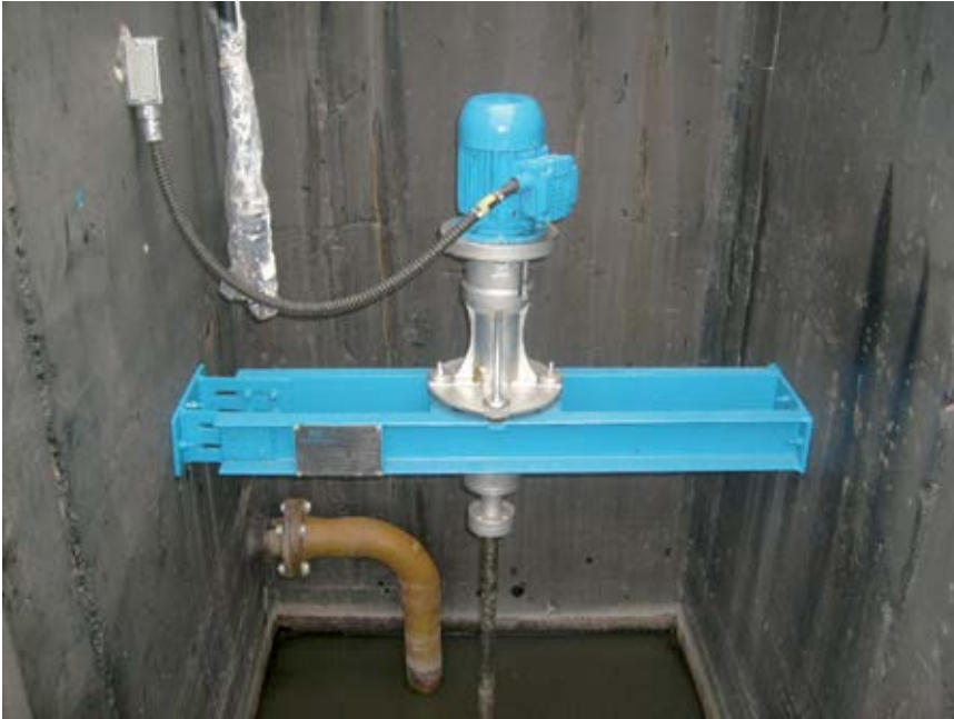
FIGURA 11.3 Misturador rápido vertical
