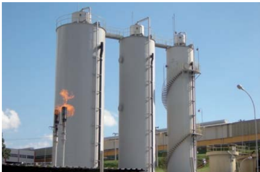
FIGURA 12.43 Reatores IC para tratamento de Efluentes
