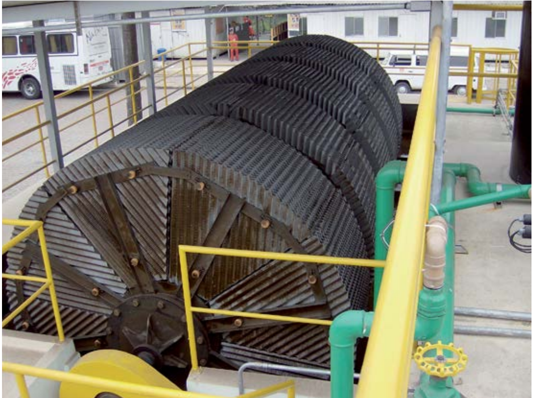
FIGURA 12.25 Disco biológico rotativo
