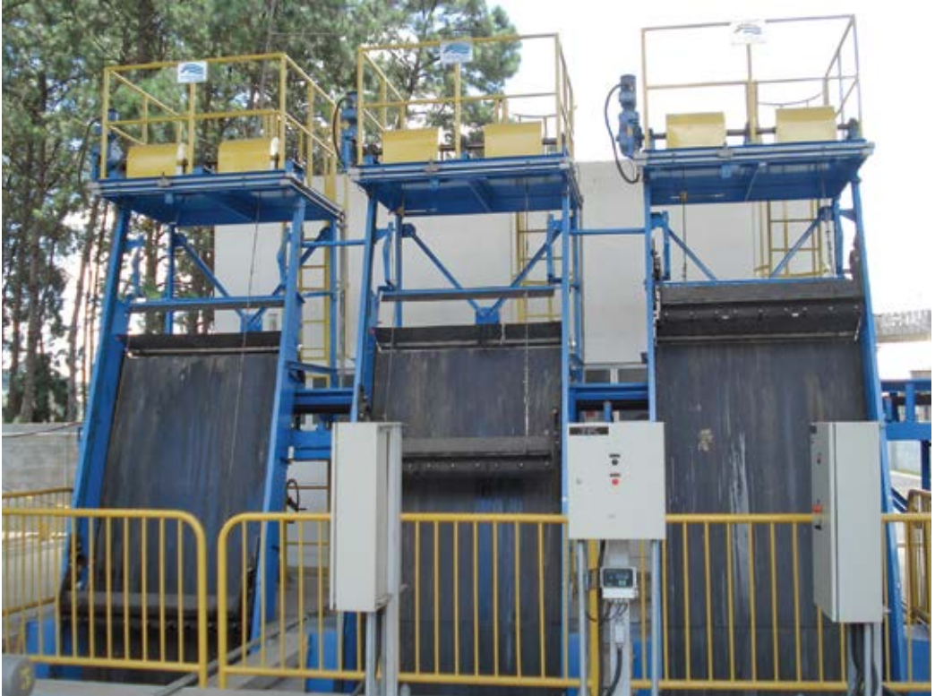
FIGURA 9.1 Grade fina mecanizada
