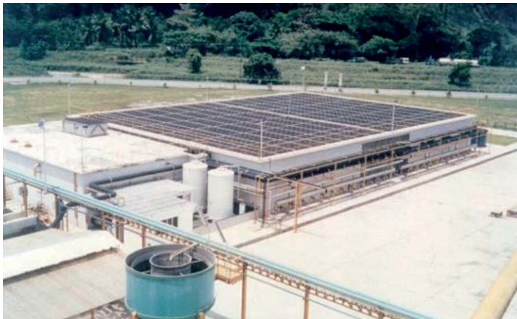
FIGURA 12.41 Reator UASB para tratamento de efluentes de cervejaria
