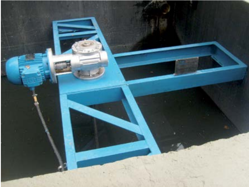
FIGURA 11.5 Floculador mecânico tipo axial
