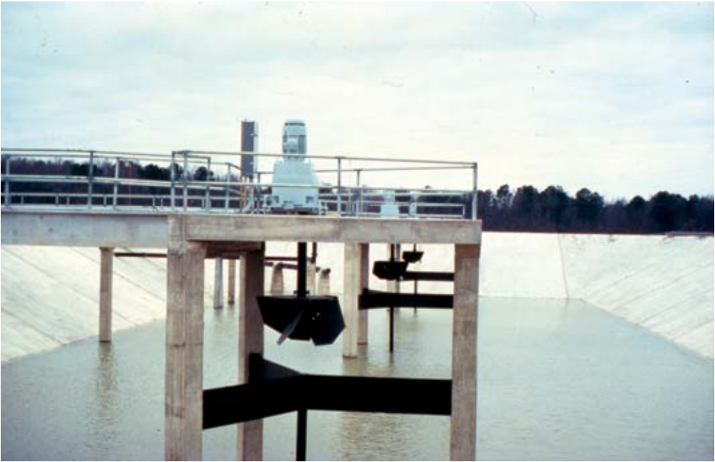
FIGURA 12.30 Aerador fixo de baixa rotação
