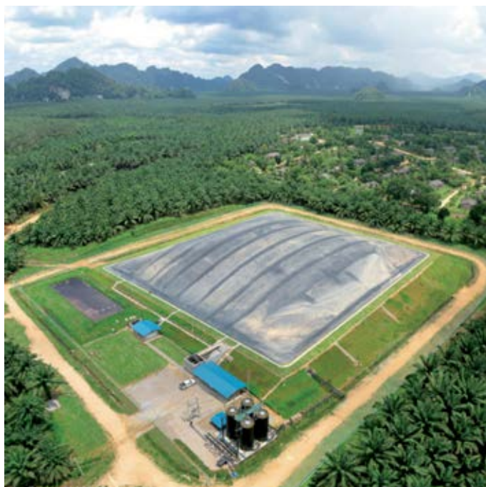
FIGURA 12.44 Lagoa anaeróbia coberta com geomembrana
