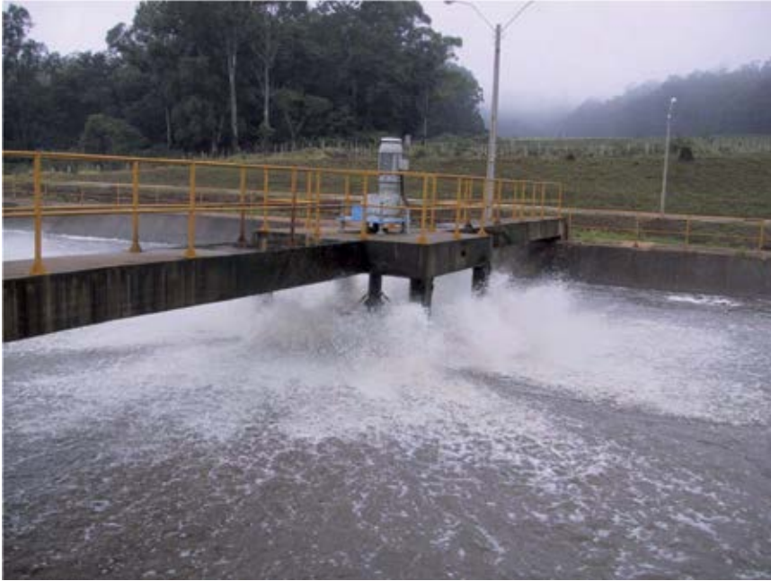
FIGURA 12.33 Aerador fixo de alta rotação (Aqua – Jet)
