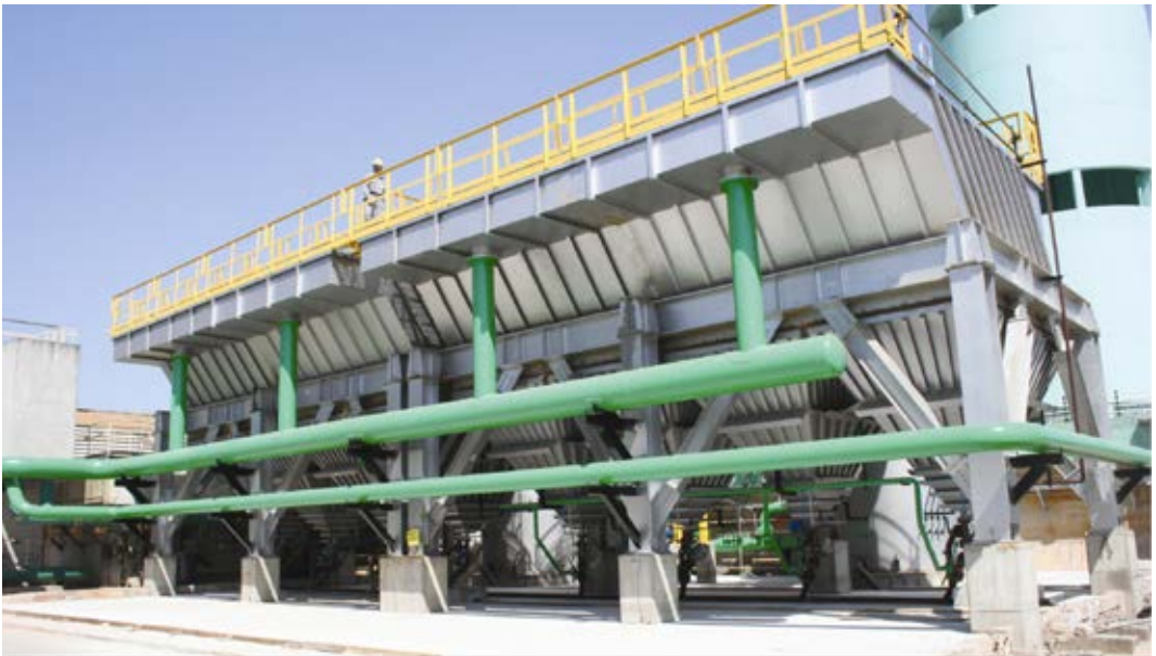
FIGURA 9.15 Decantadores lamelares
