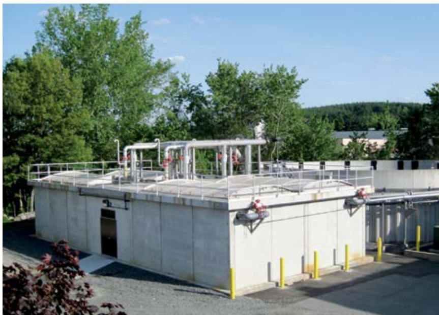
FIGURA 12.45 Reator Anaeróbico a Membrana – Processo ADI-AnMBR®
