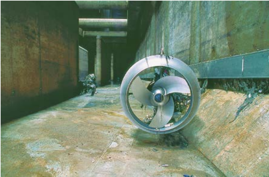
FIGURA 11.4 Misturador submersível
