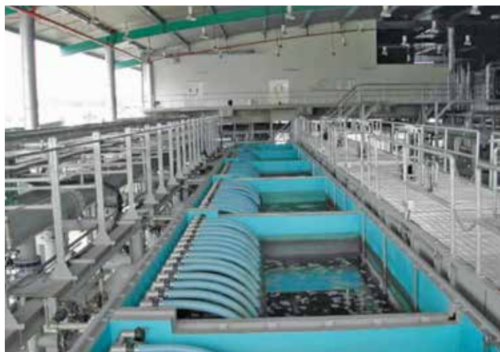
FIGURA 14.4 Unidade de microfiltração
