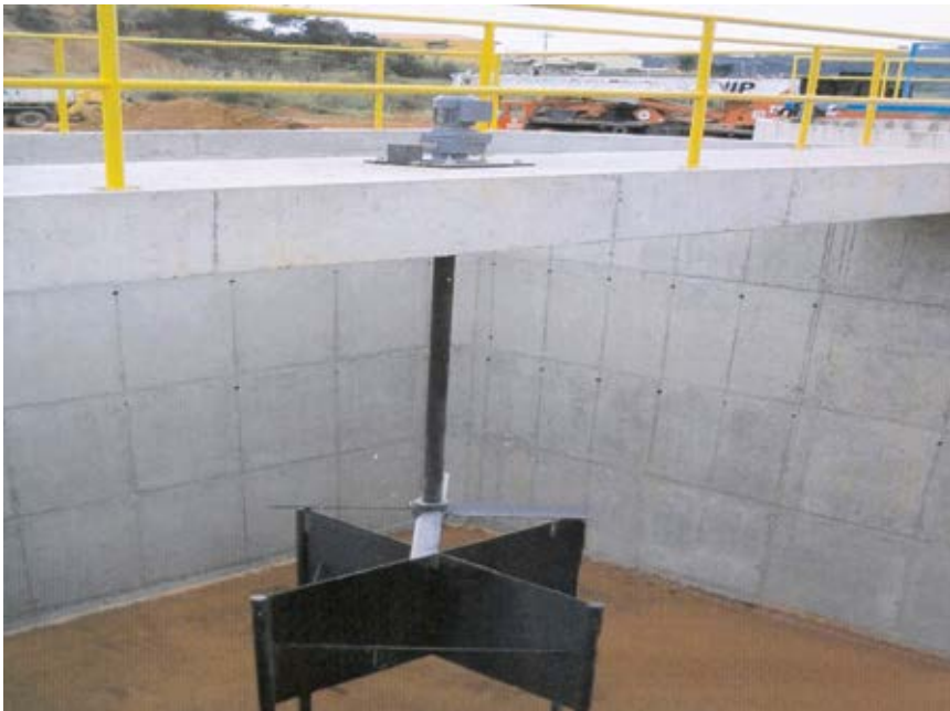
FIGURA 11.6 Floculador - fluxo axial
