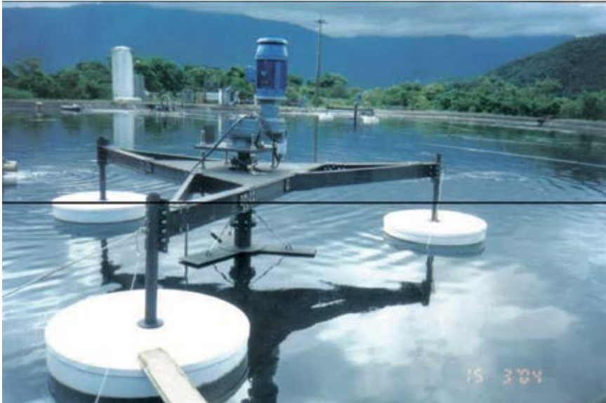
FIGURA 12.31 Aerador flutuante de baixa rotação
