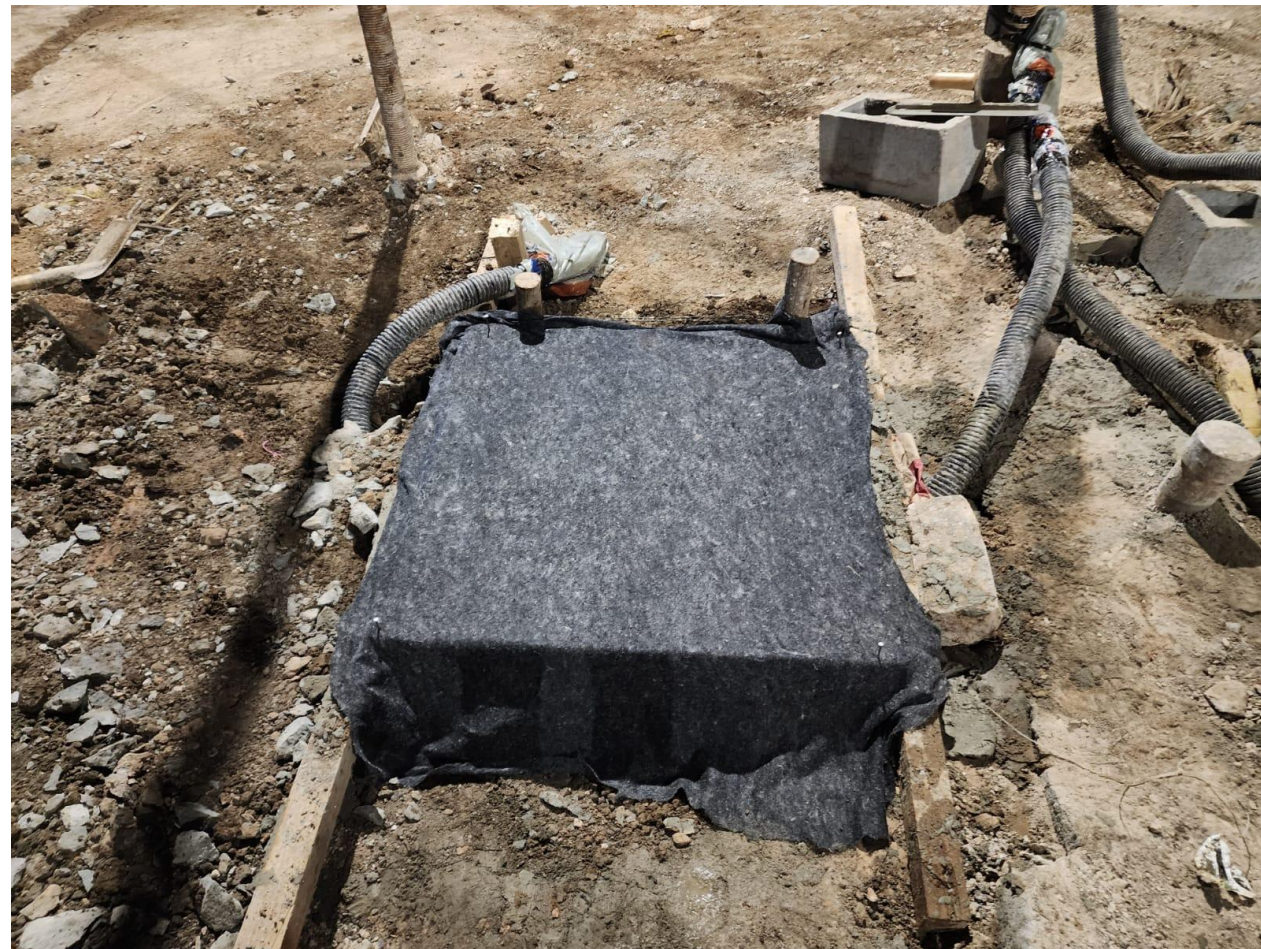
Hidratação do bloco pra evitar patologias
