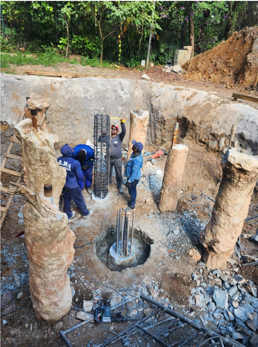
Arrasamento da ET-02 e colocação da armadura ET-01
