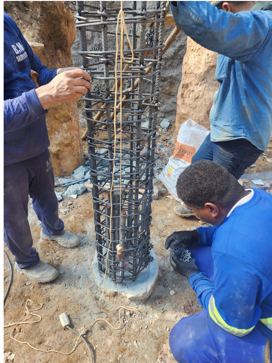
Verificação do prumo da armadura
