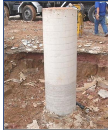
ESTACAS TESTE (60 cm): P17A, P126 (2m curta) e P132
