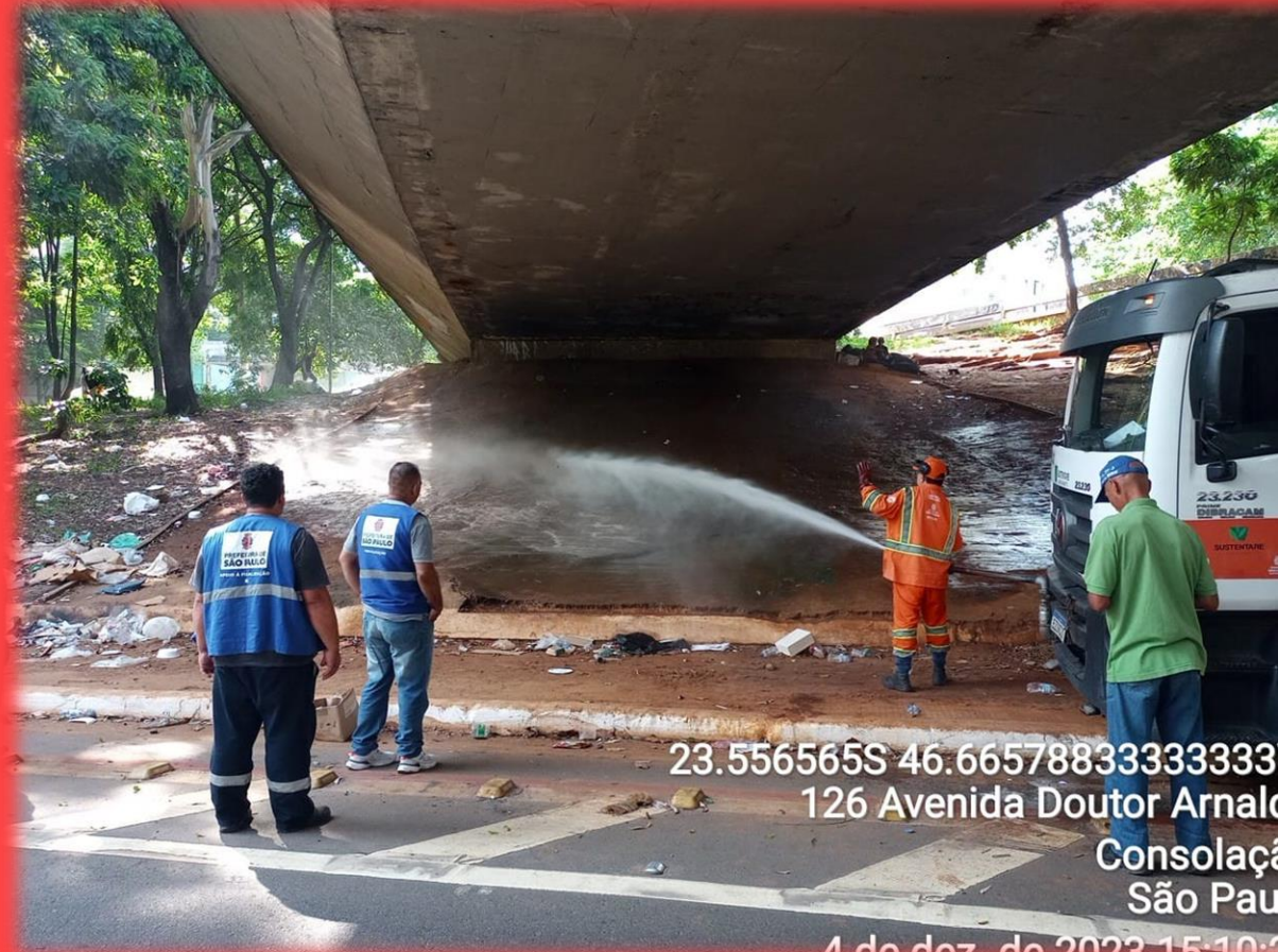
23.55621833333333S 46.66538333333333W 31 Viaduto Okuhara Koei Consolação São Paulo 4 de dez. de 2023 15:07:19
