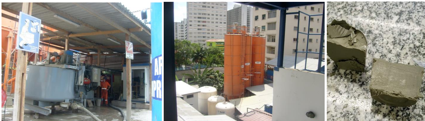
Figura 11, 12 e 13 – Central de graute bicomponente e aspecto do graute homogêneo, sem grumos (Arquivo pessoal).
