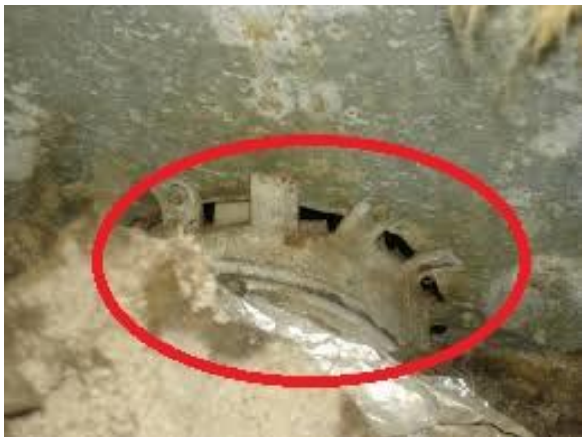
Instalação de Dutos Flexíveis
