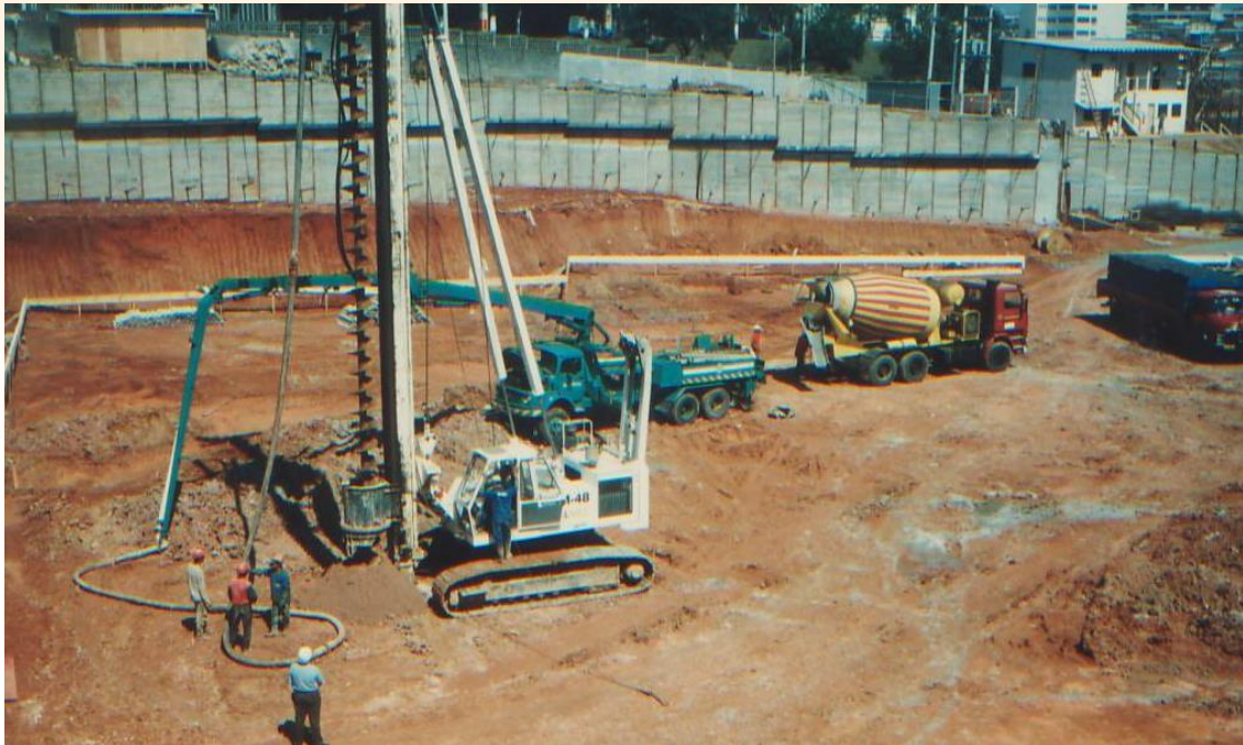
(a) introdução do trado (b) concretagem sem rodar o trado (c) introdução da armadura (cuidado no início da concretagem!!!!!! – slide 33)
