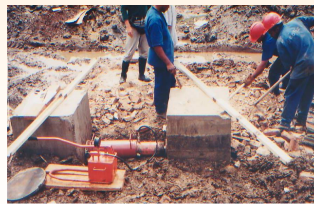
macaco hidráulico entre duas estacas
