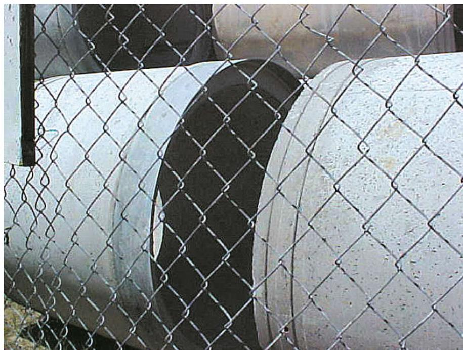
Detalhe do encaixe entre tubos para Pipe Jacking e entre segmentos de tubo cravado
