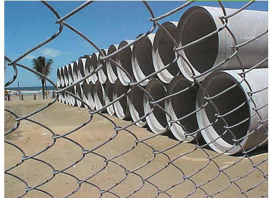
Vista de estoque de tubos de concreto Pré-moldados, para Pipe Jacking
