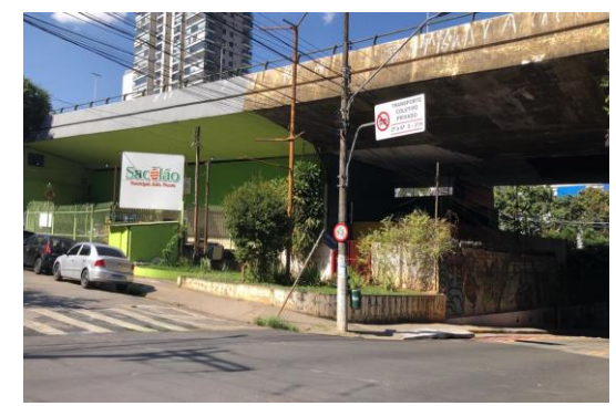
VIADUTO SOBRE A RUA JOÃO MOURA FOTOS ATUAIS (2023)
