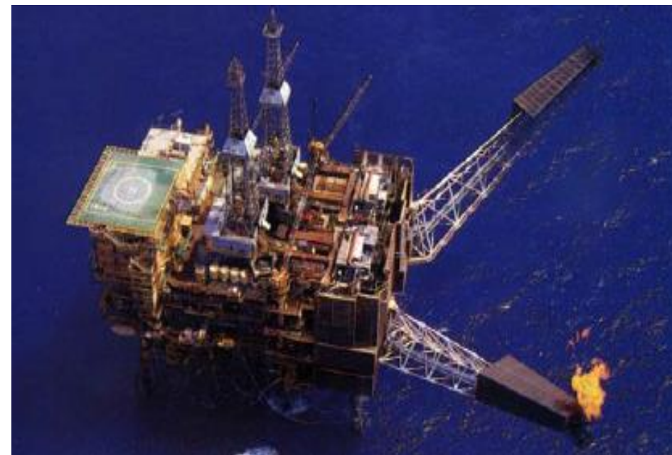
Plataforma Fija PRA-I Santos SP – Unidade de Bombeo – 2010 Producción: 750000 BBP/d
