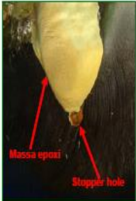
Extremidade inferior da Trinca 3 no brace 05
