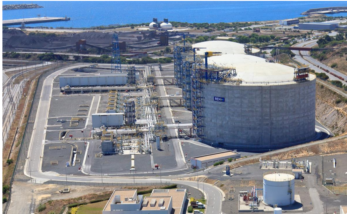
Foto: Terminal Terrestre de Armazenagem e Regaseificação em Sines (PT)
