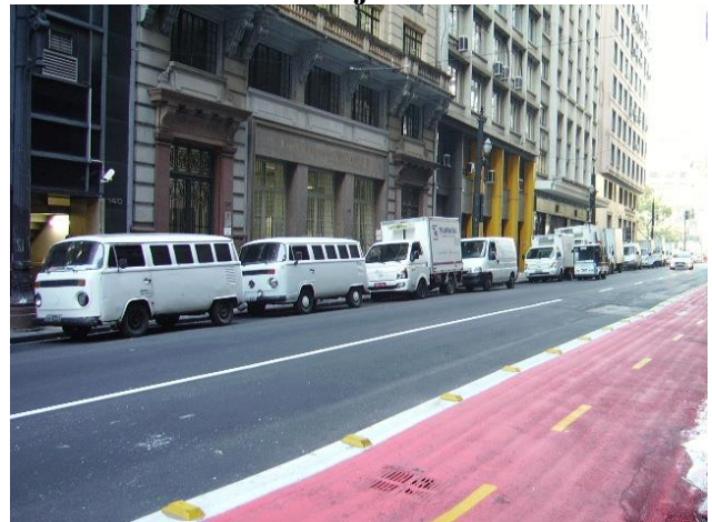
boca de leão na faixa central da rua
