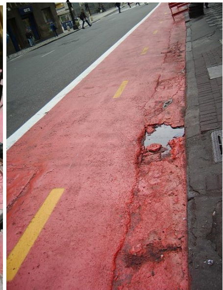
sarjeta destruída
