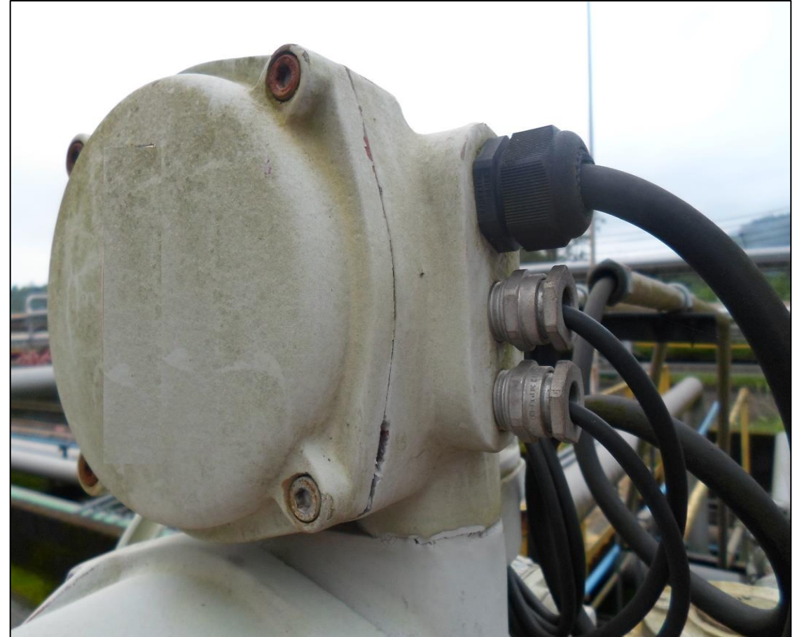
Invólucro metálico Ex “d” com prensa-cabo Ex “e” Falhas de projeto, montagem e inspeção inicial
