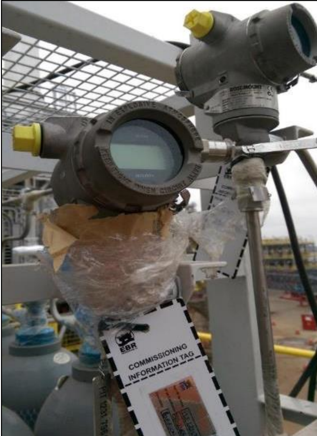
Invólucro Ex “d” com entrada de cabo não utilizada sem o devido plugue metálico Ex “d” Falhas de projeto, montagem e inspeção inicial
