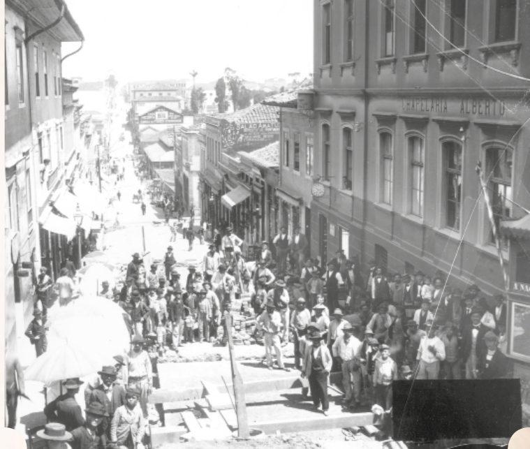
Vista da ladeira São João, atual avenida São João, a partir da rua São Bento em direção ao Vale do Anhangabaú, destacando as obras de construção de caixa para transformador das linhas subterrâneas de transmissão de energia para alimentação da linha de bonde elétrico. Data: 10/02/1900
