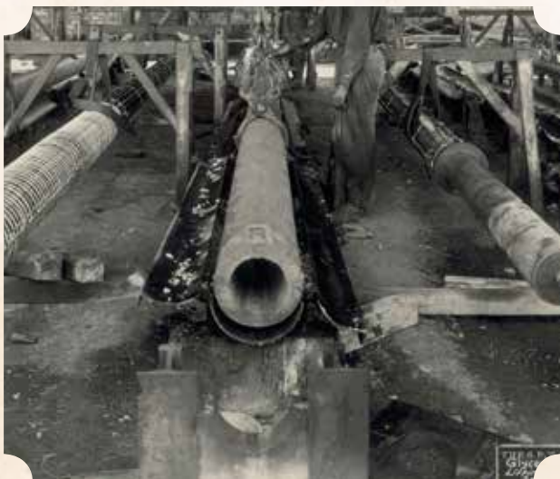
Fábrica de postes do Glicério. Retirada de poste de 35 polegadas. Data: 1930
