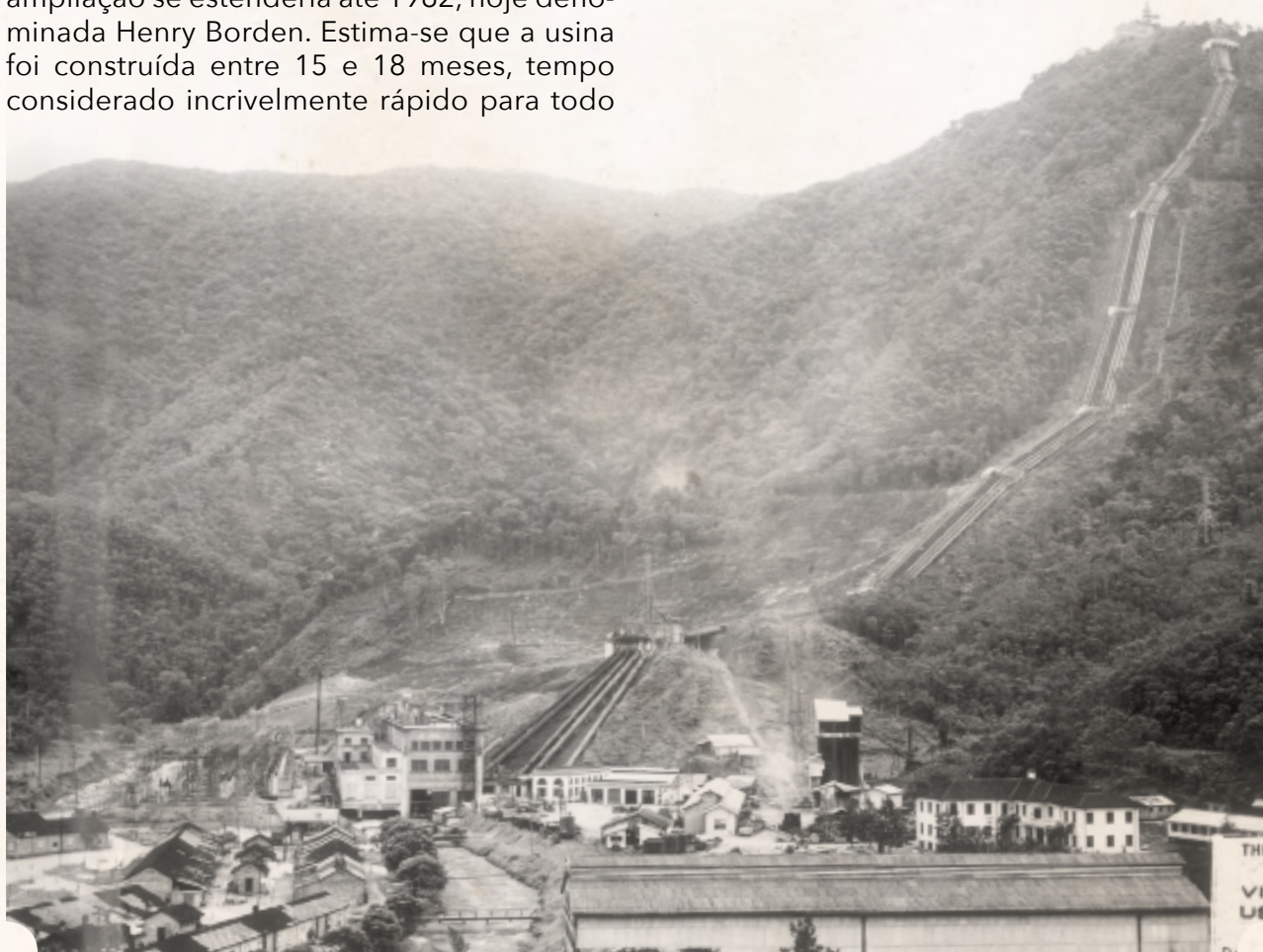
Vista geral da Usina de Cubatão. Data: 1948
