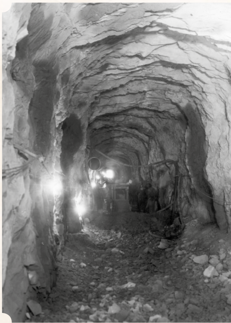
Obras da Usina Subterrânea de Cubatão. Data: 1954
