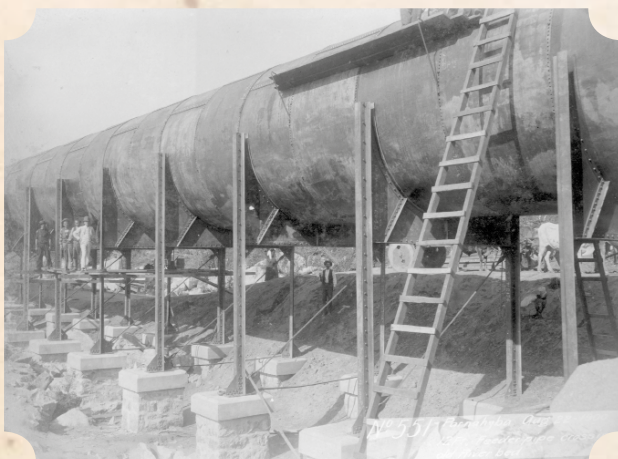
Obras do conduto forçado, entre os dois reservatórios da UHE Parnaíba, em trecho sobre antigo leito do rio Tietê. Data: 22/08/1900
