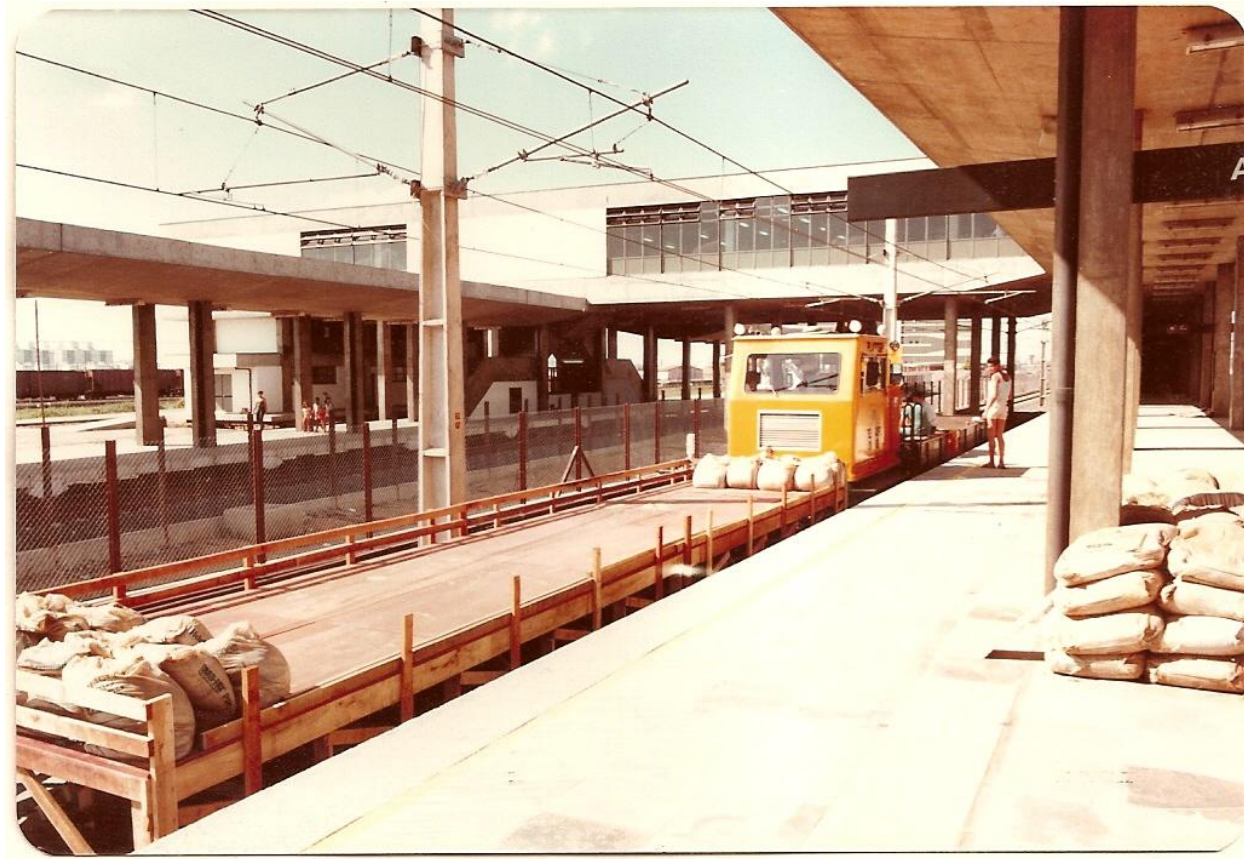
Testes do IPT na via da Trensurb em 1985
