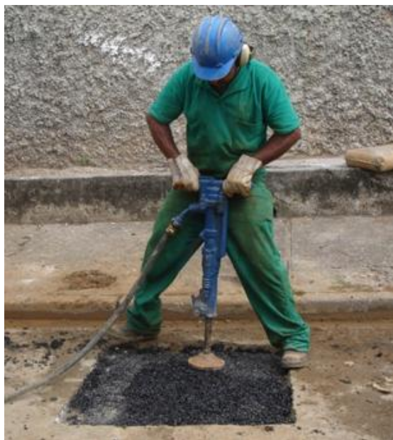
Asfalto a Frio (PMF)
