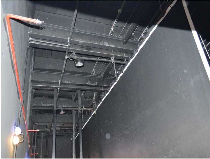
Sprinkler sidewall com defletor danificado
