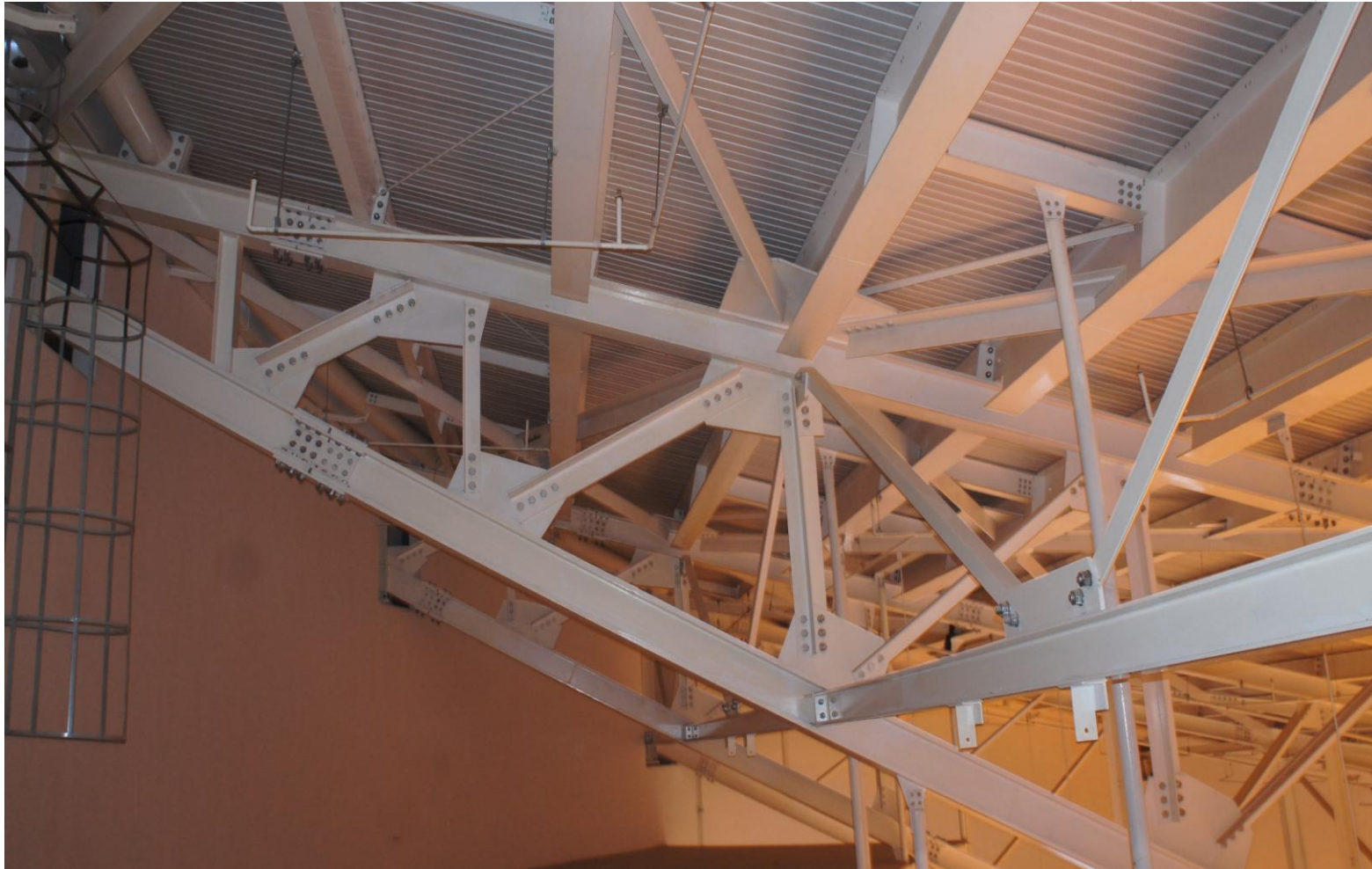
Sprinklers K80 instalados a 15 m de altura
