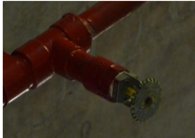
Sprinkler em pé instalado pendente
