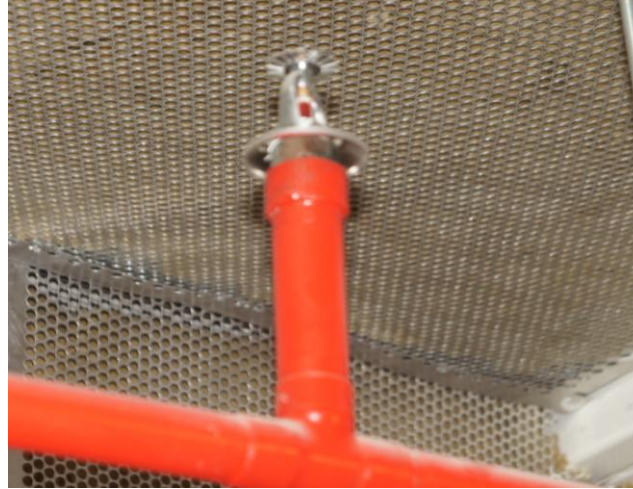
Sprinkler pendente instalado em pé
