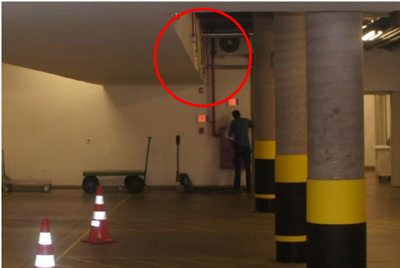
Sprinklers obstruídos
