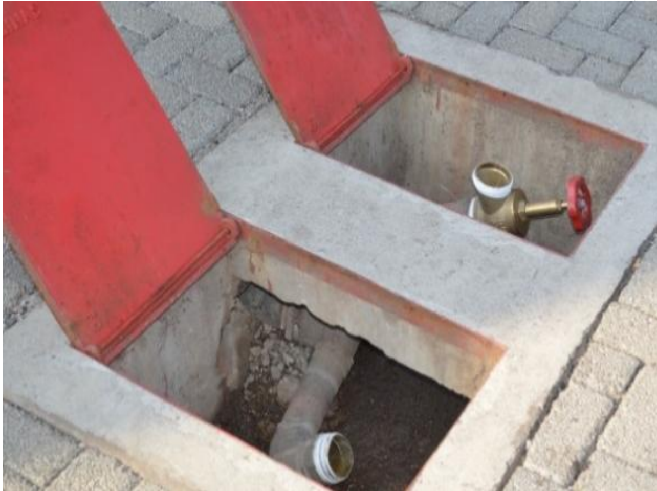
Tomadas de recalque irregulares
