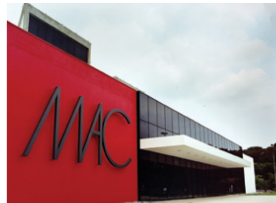
Fachada do MAC USP
