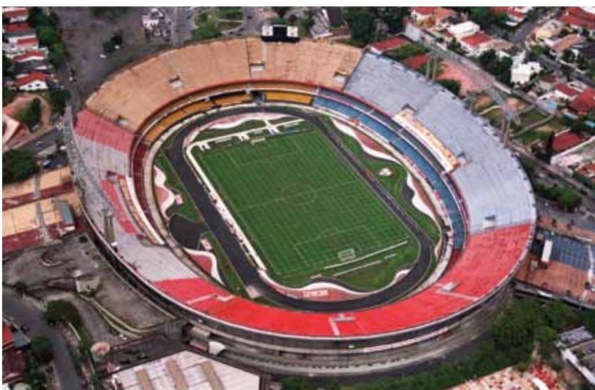
Estádio do Morumbi
