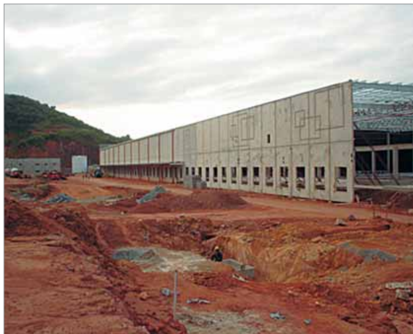
Parte do CD durante as obras
