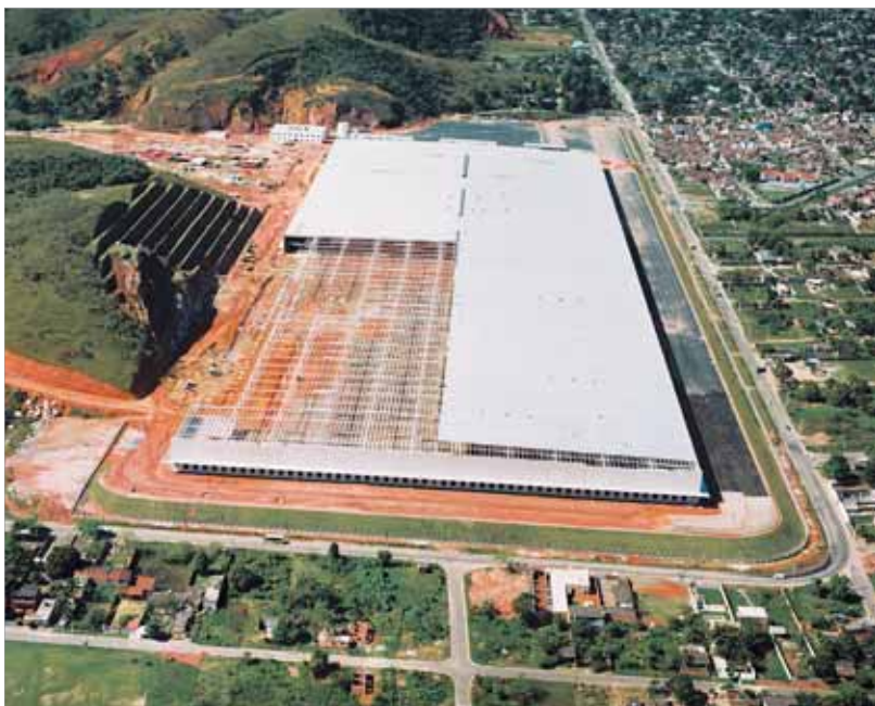
Cobertura em duas águas
