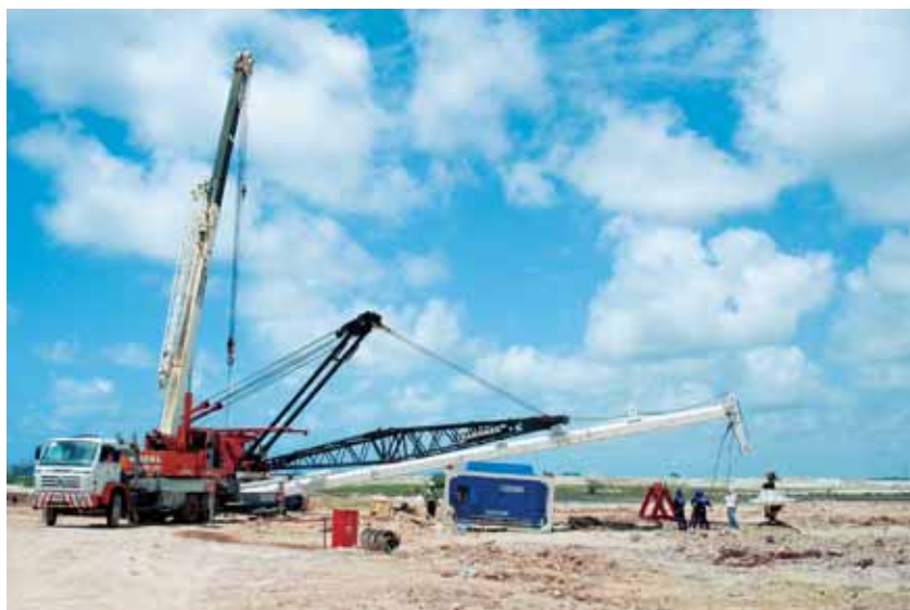
Obras do empreendimento
