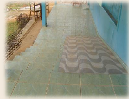
Pacajá Construção de rampas de acesso para portadores de necessidades especiais
