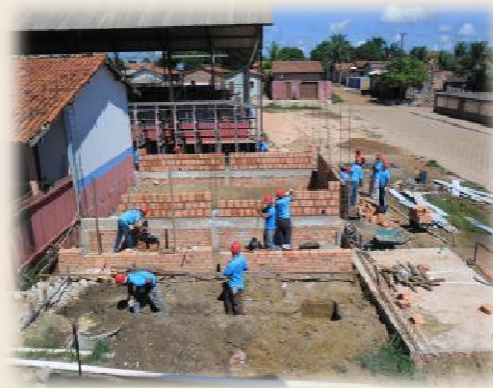
Vitória do Xingú Construção de salas de aula
