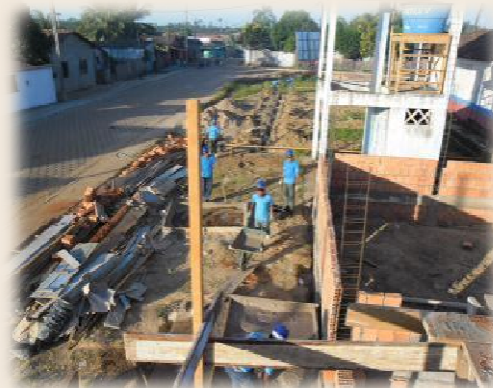
Anapú Construção de Sala de aula para portadores de necessidades especiais
