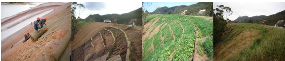
Fig. 1 – Aplicação de biomantas e recuperação da área ao longo do tempo
