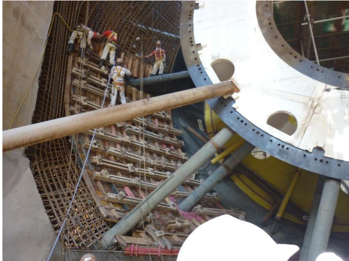
Estrutura para fixação do bulbo da turbina.
