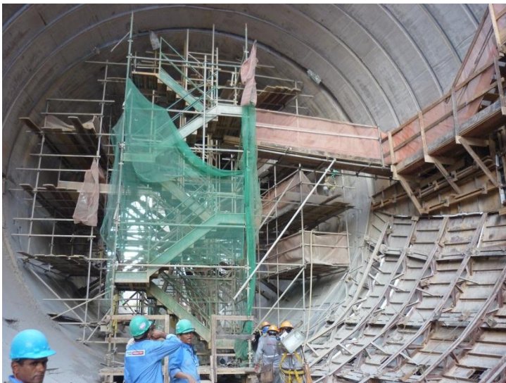
Vista do anel de descarga da turbina tipo do bulbo.
