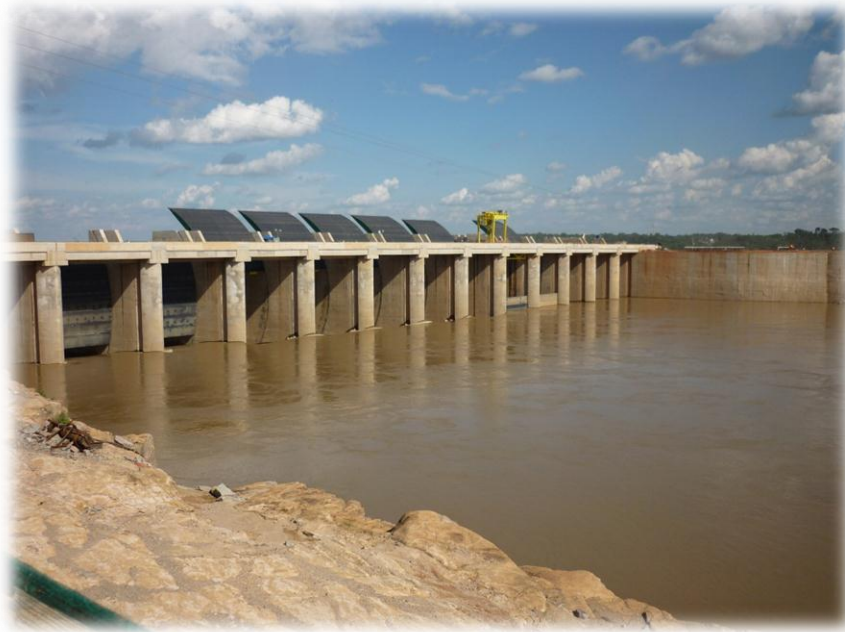
Vista dos “Piers” e das Comportas tipo Segmento.
