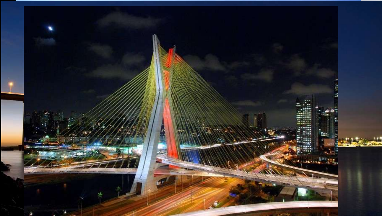
Ponte Octávio Frias de Oliveira, São Paulo, SP AM Ponte Ponte Newton Navarro, Natal, RN
