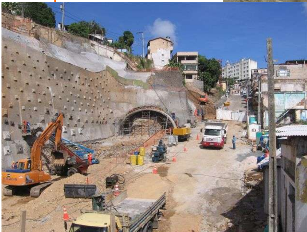
TÚNEL ESTRADA DA RAINHA (2005)
