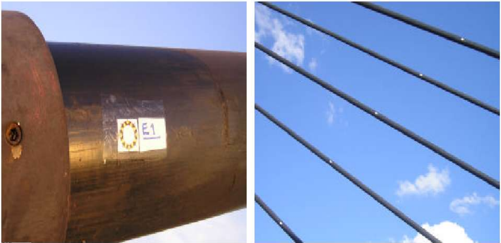
Figura 2.4 – Alvos instalados nos estais, na base do estai e nos meios dos estais
