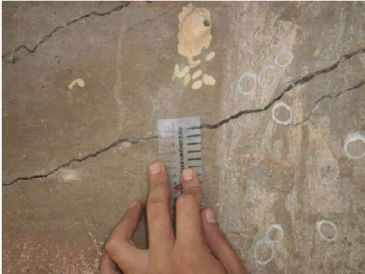
Medição da espessura da fissura com uso de fissurômetro
