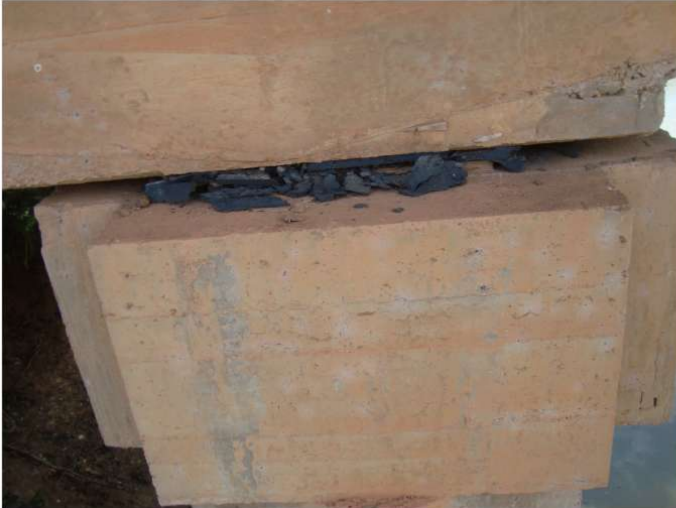
Aparelho de apoio, pilar P2, lado montante
