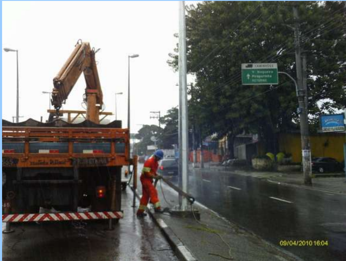
Instalação de Poste Metálico
