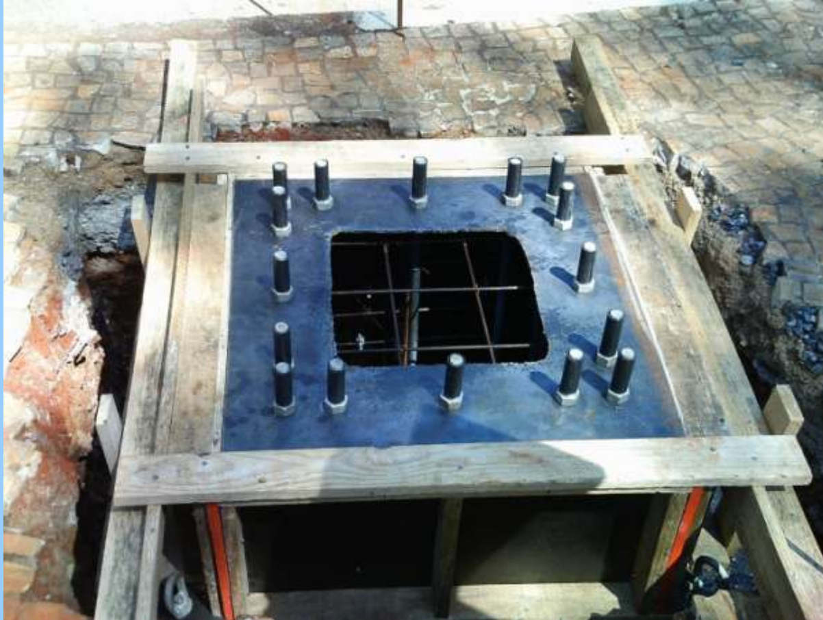
Construção de Base para Poste Metálico
