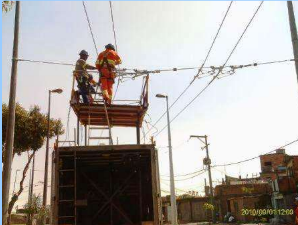
Grampeamento do Fio de Contato
