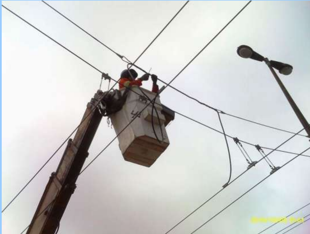
Instalação do Cabo de Interligação
