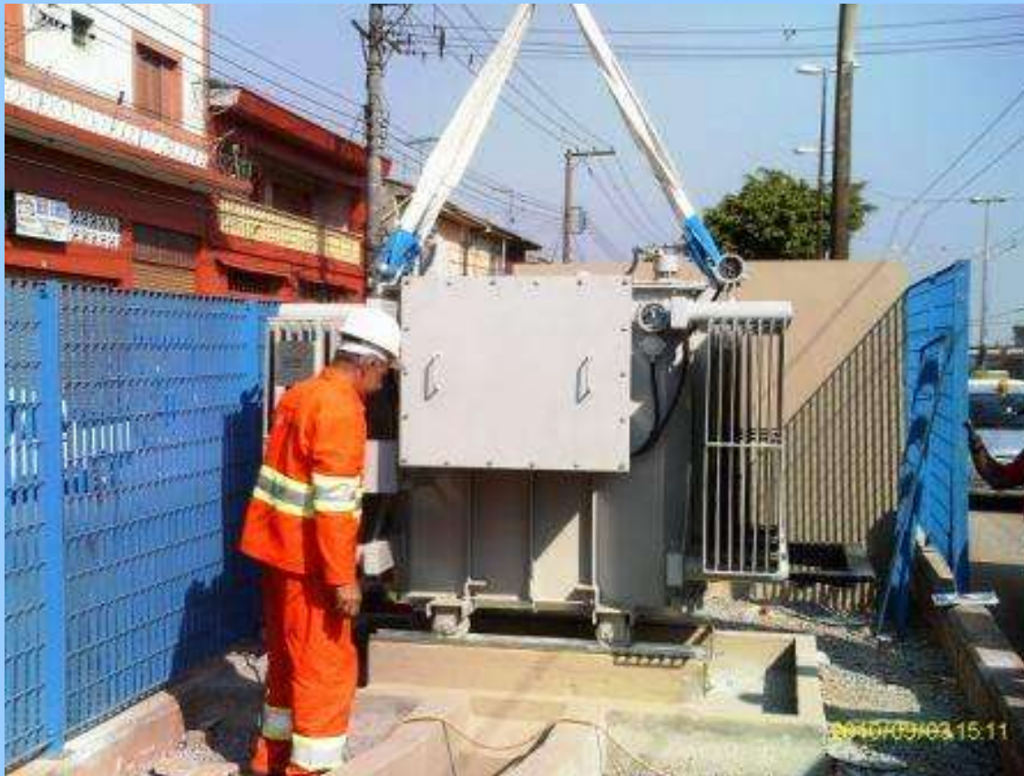
Instalação do Transformador
