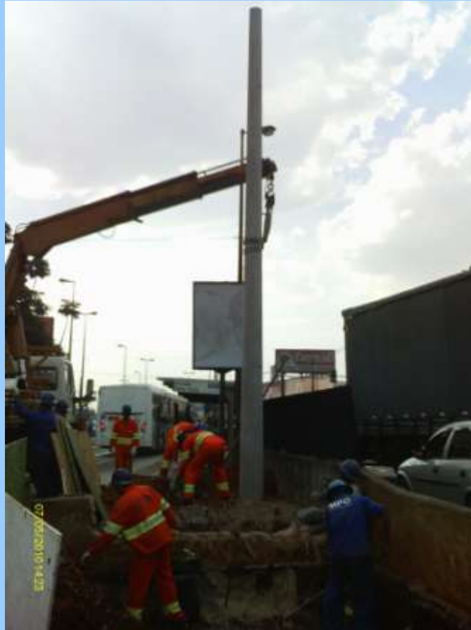
Instalação de poste de concreto
