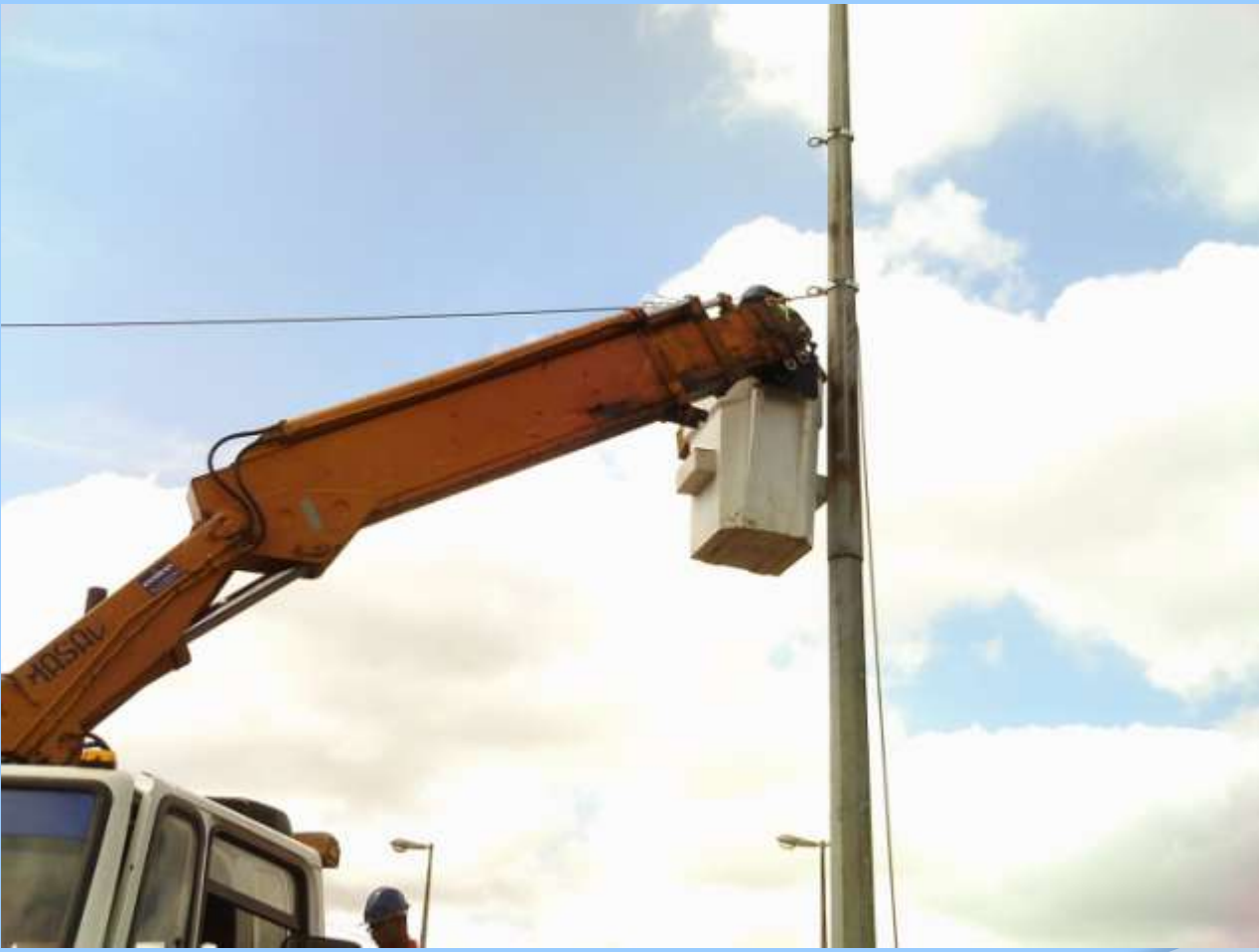
Instalação dos tirantes
