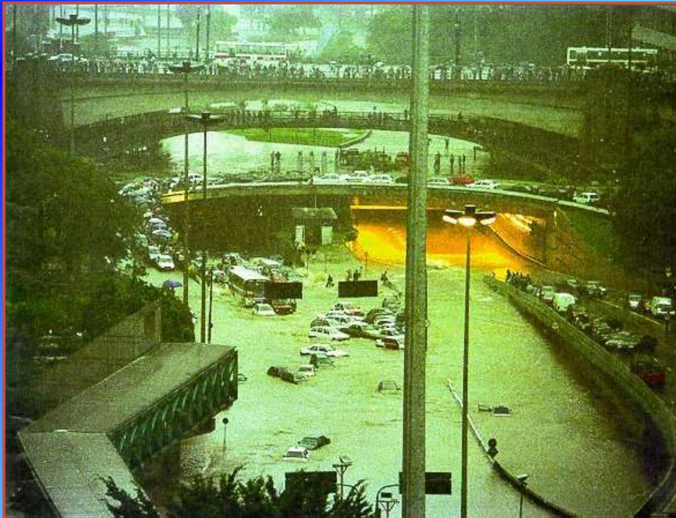
A Inundação do Túnel do Anhangabaú (Centro de São Paulo) em 01.03.1999
