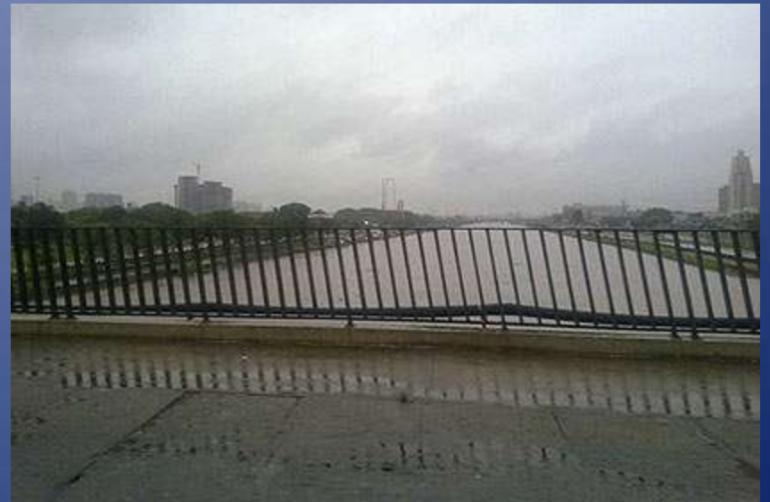
Vista da Ponte da Casa Verde
