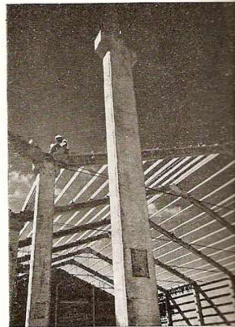
Fig. 41.—Relleno del apoyo de los dinteles.
