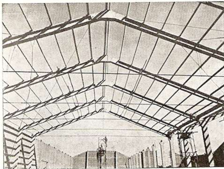
Fig. 40.—Cobertizo durante el montaje.
