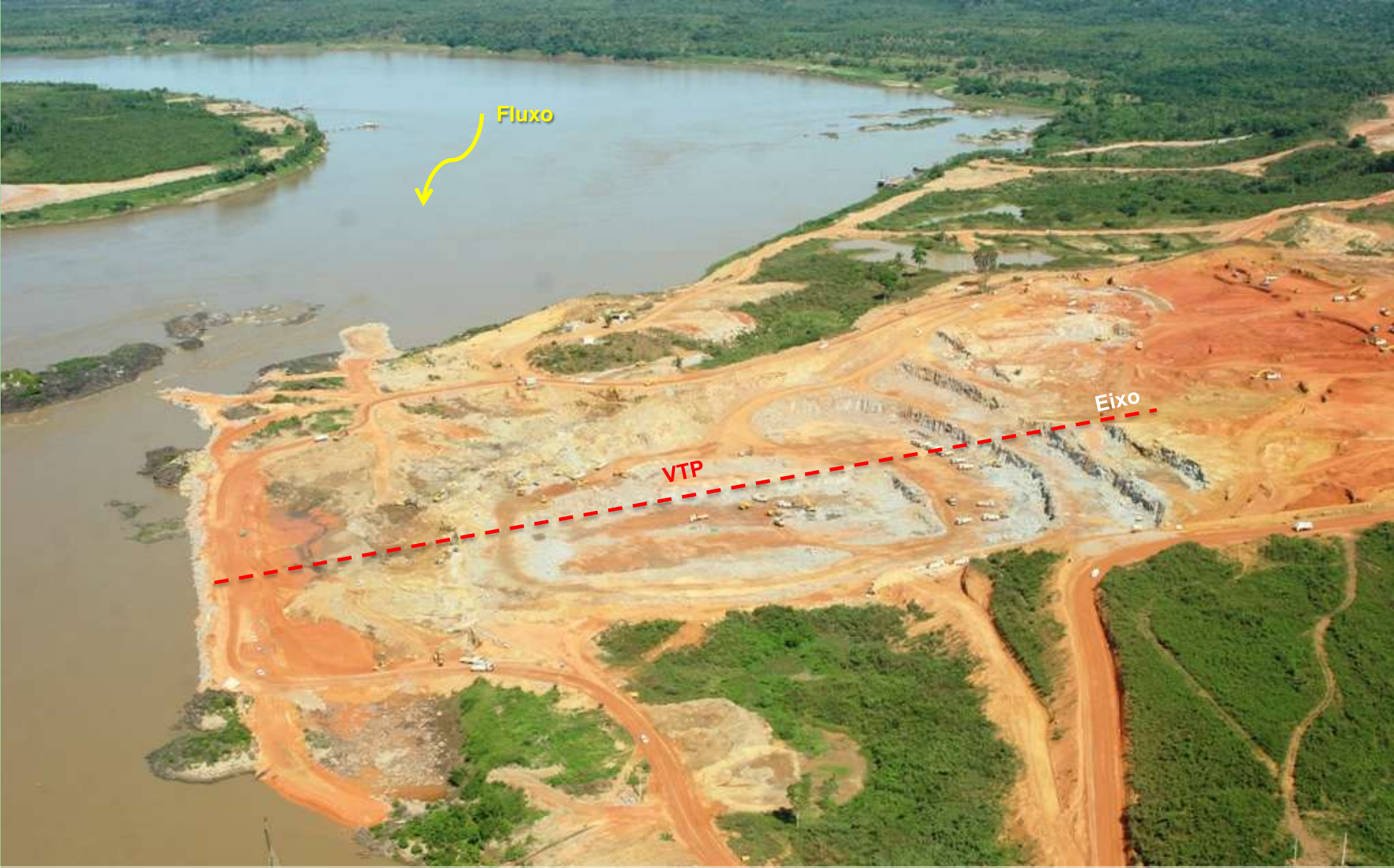
Vista Jusante da Margem Esquerda
