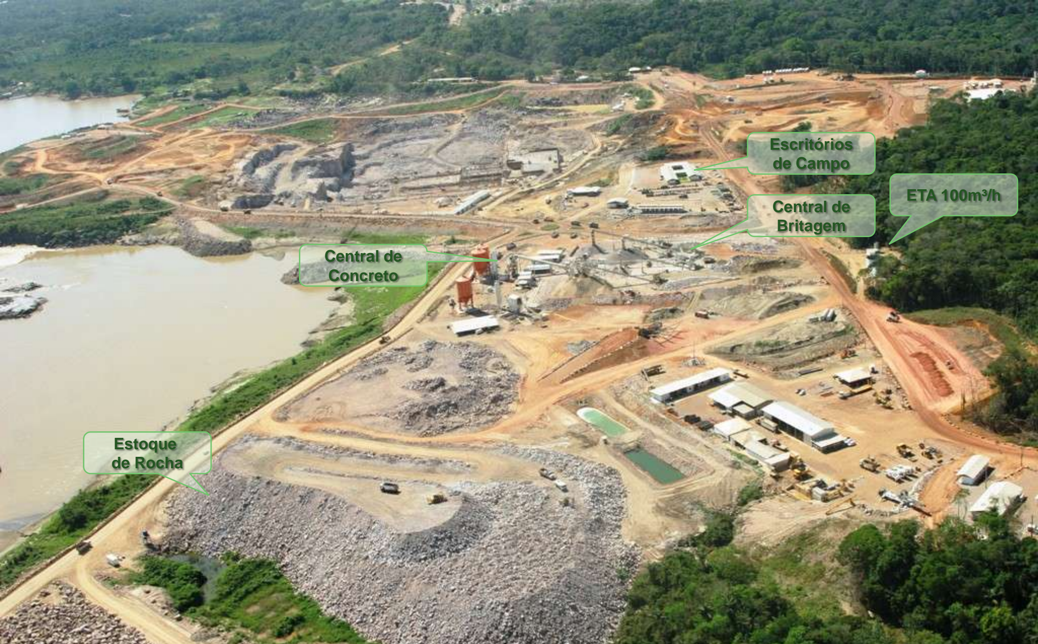
Vista do Canteiro da Margem Direita
