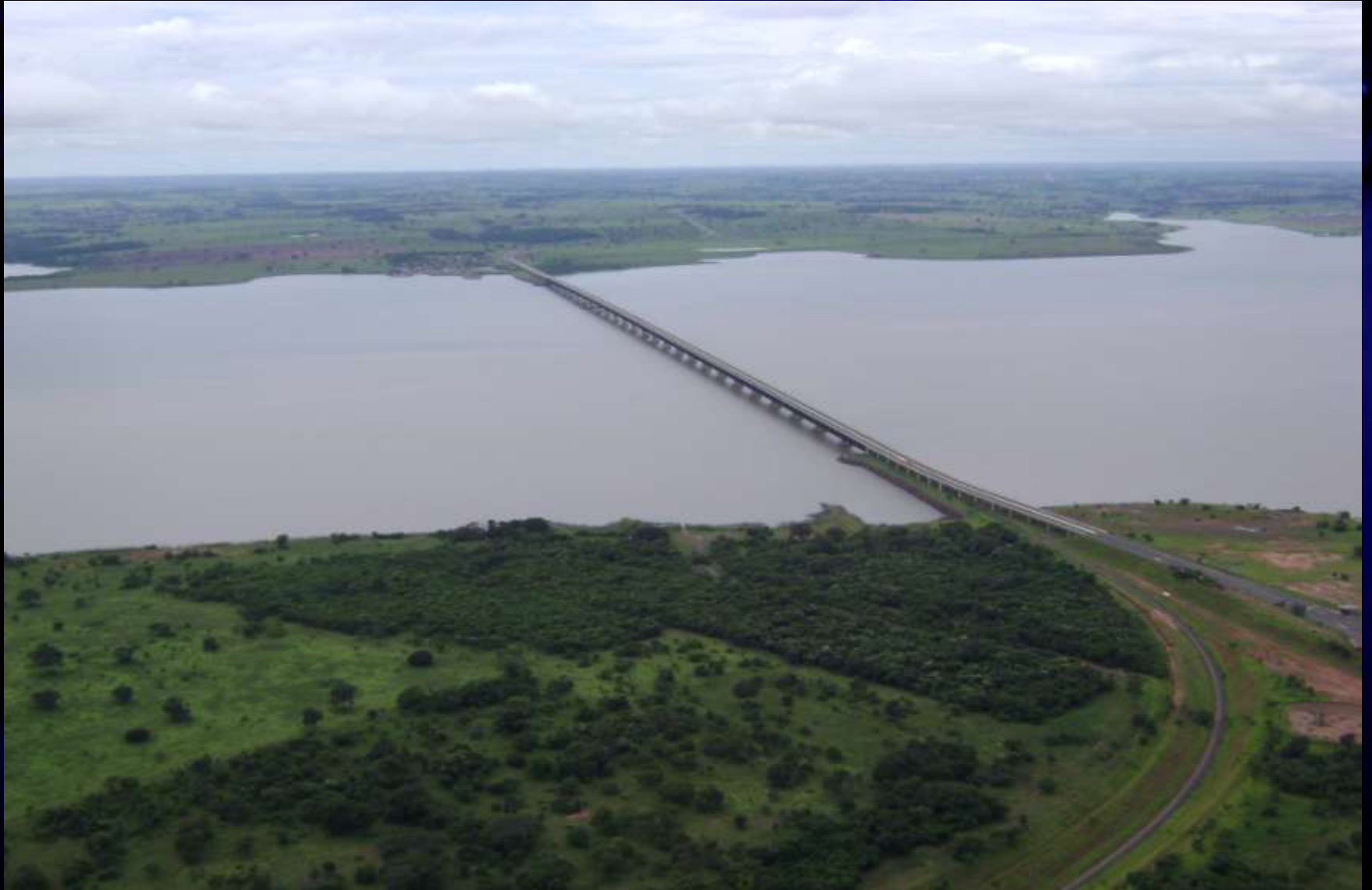
Ponte Rodo-ferroviária – Rio Paraná
