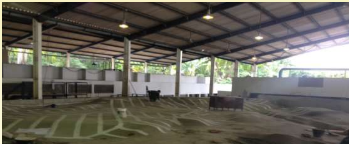
Construção do modelo reduzido tridimensional
