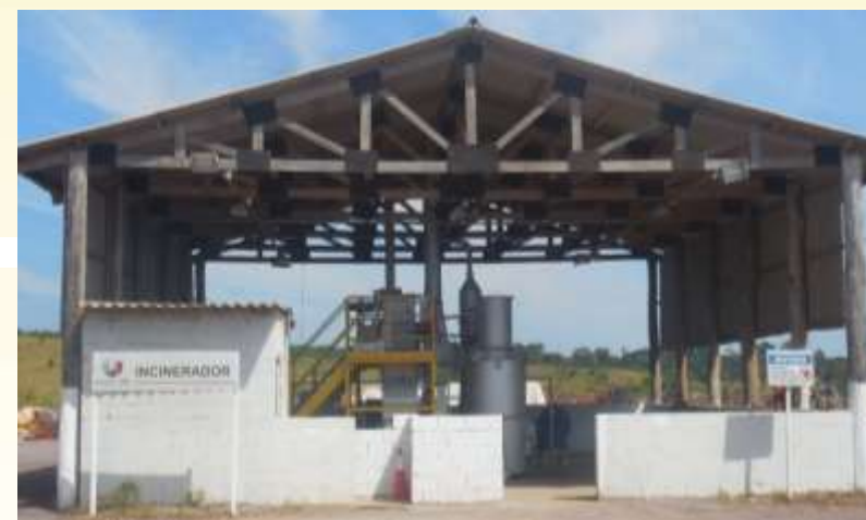
Incinerador para tratamento de resíduos Classe I
