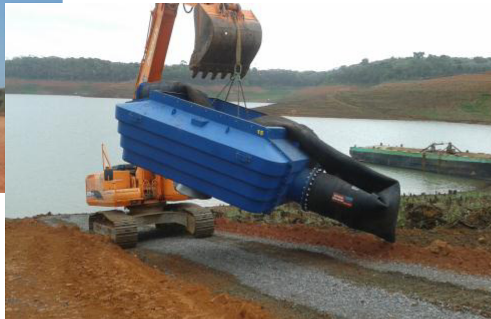
Movimentação com escavadeira
