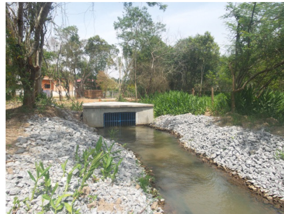
Bombeamento de 1,0 m 3 /s do Rio Guaió para o Represa Taiacupeba
