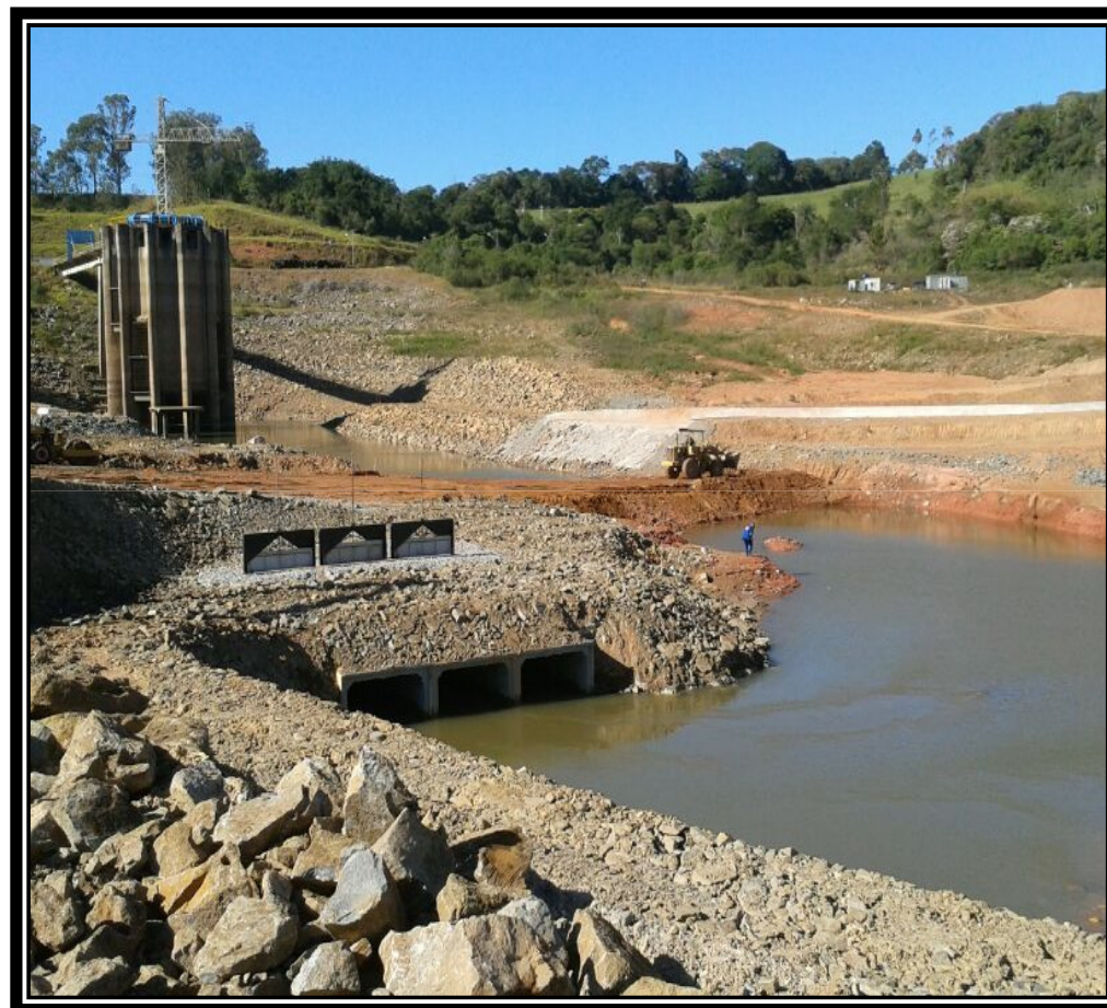
12/05/2014 – Barragem e Vertedouro.
