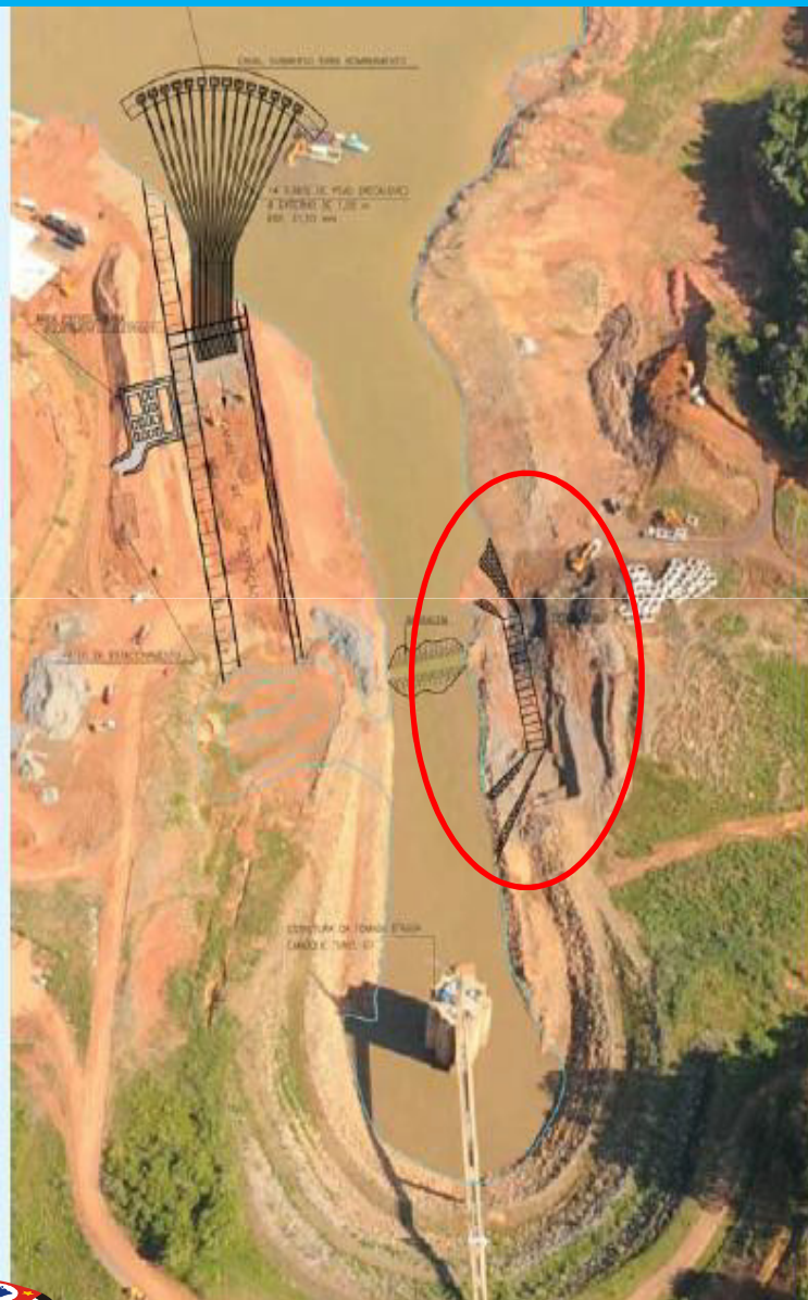
04/04/2014 – Colocação das Aduelas do vertedouro.
