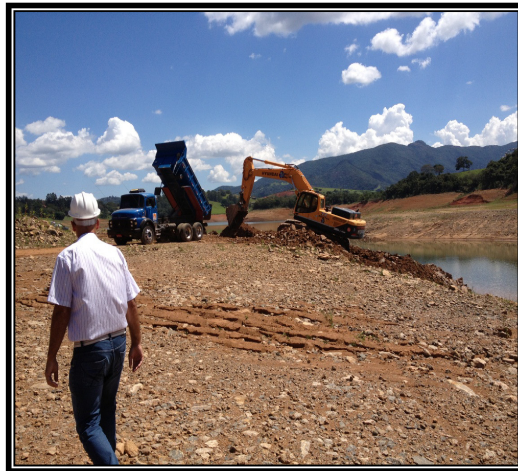
17/03/2014 - Início dos trabalhos de escavação do canal de dissipação.
