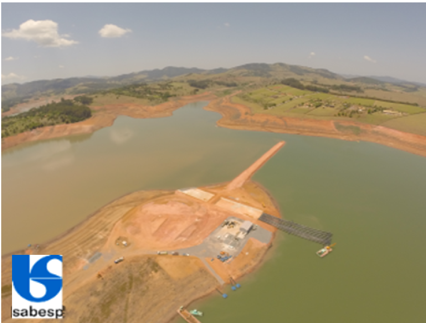
Vista geral com montagens concluídas aguardando o fechamento final da barragem no atingimento da cota 817,00 m
