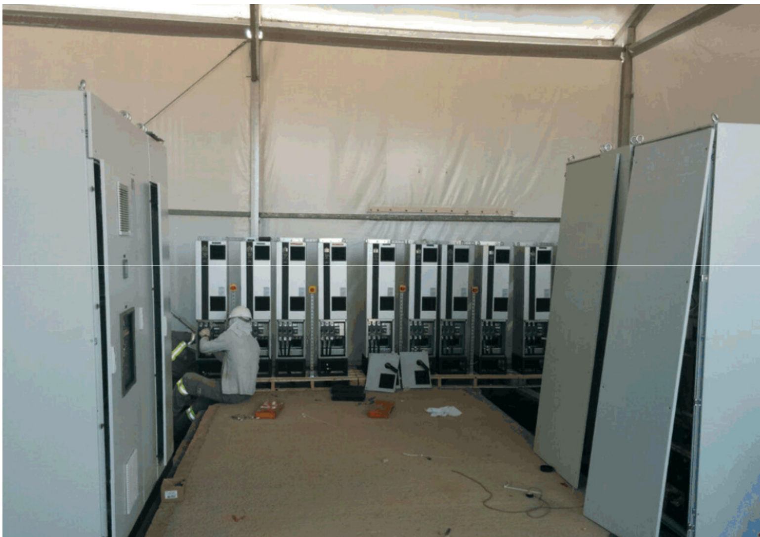
Mão de Obra Própria da Sabesp
