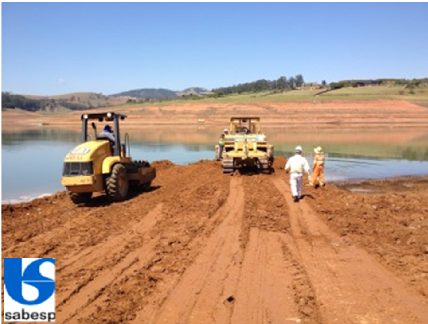
Execução do maciço da barragem, com o lançamento da mistura argila/brita
