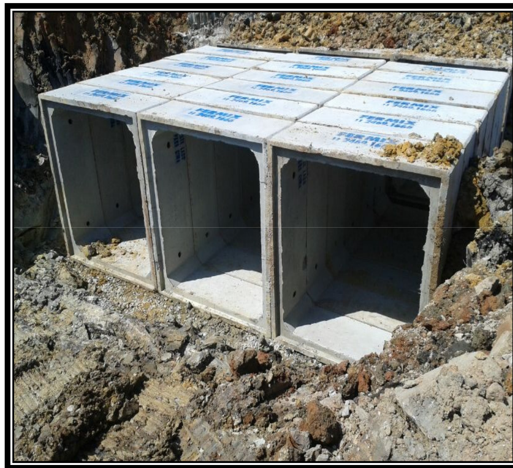
04/04/2014 – Colocação das Aduelas do vertedouro.
