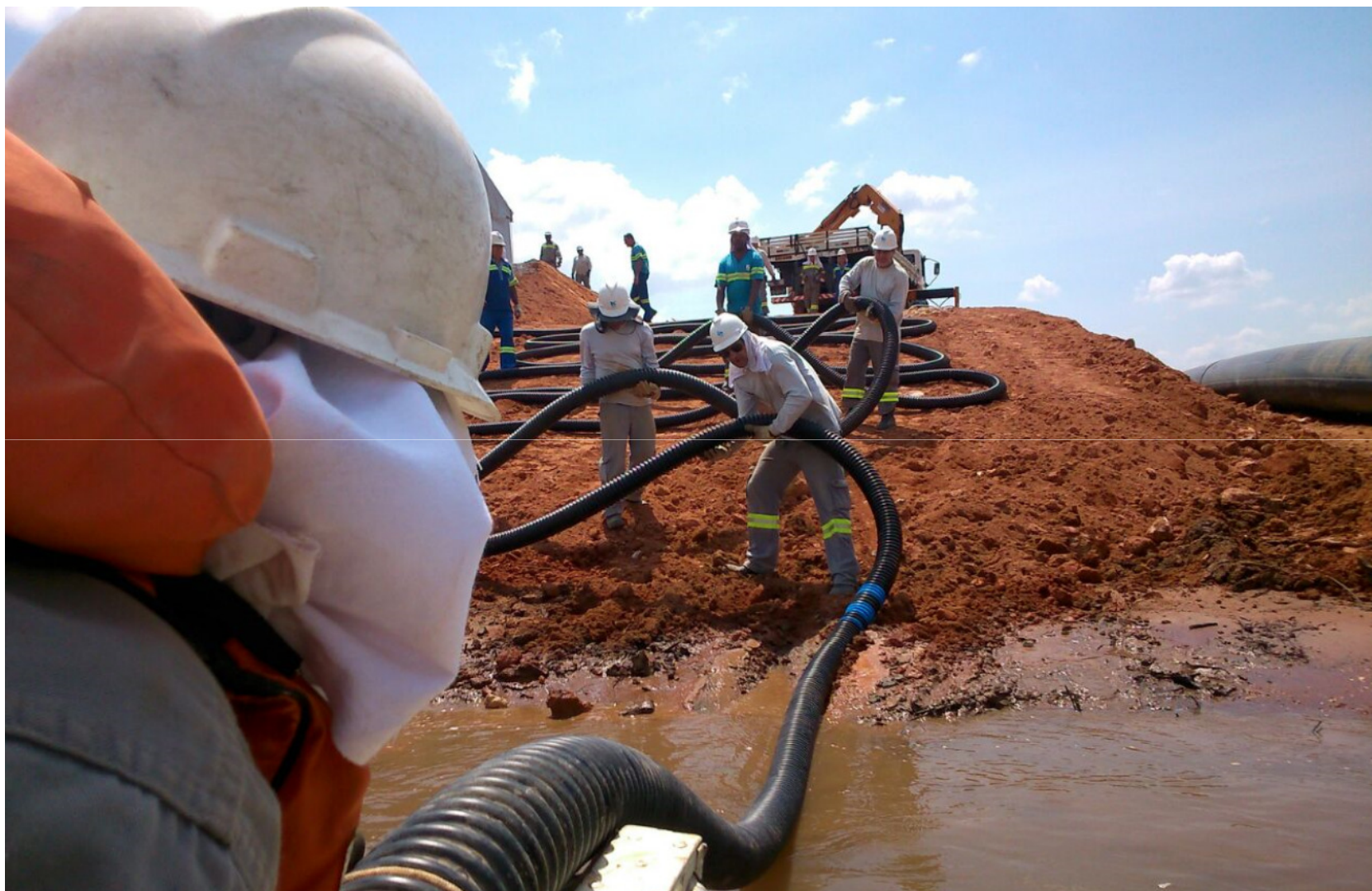
Mão de Obra Própria da Sabesp
