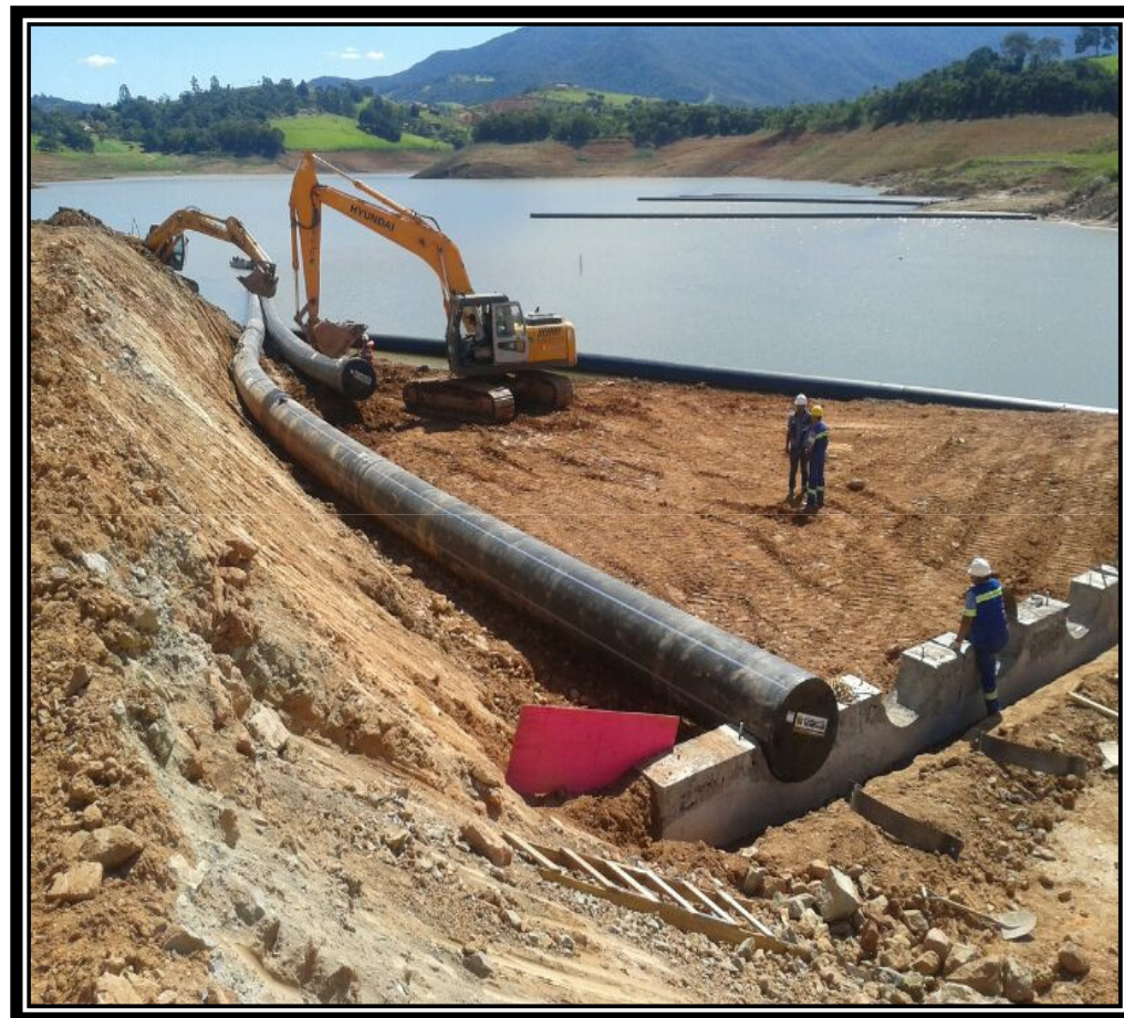
29/04/2014 – Posicionamento das Tubulações.
