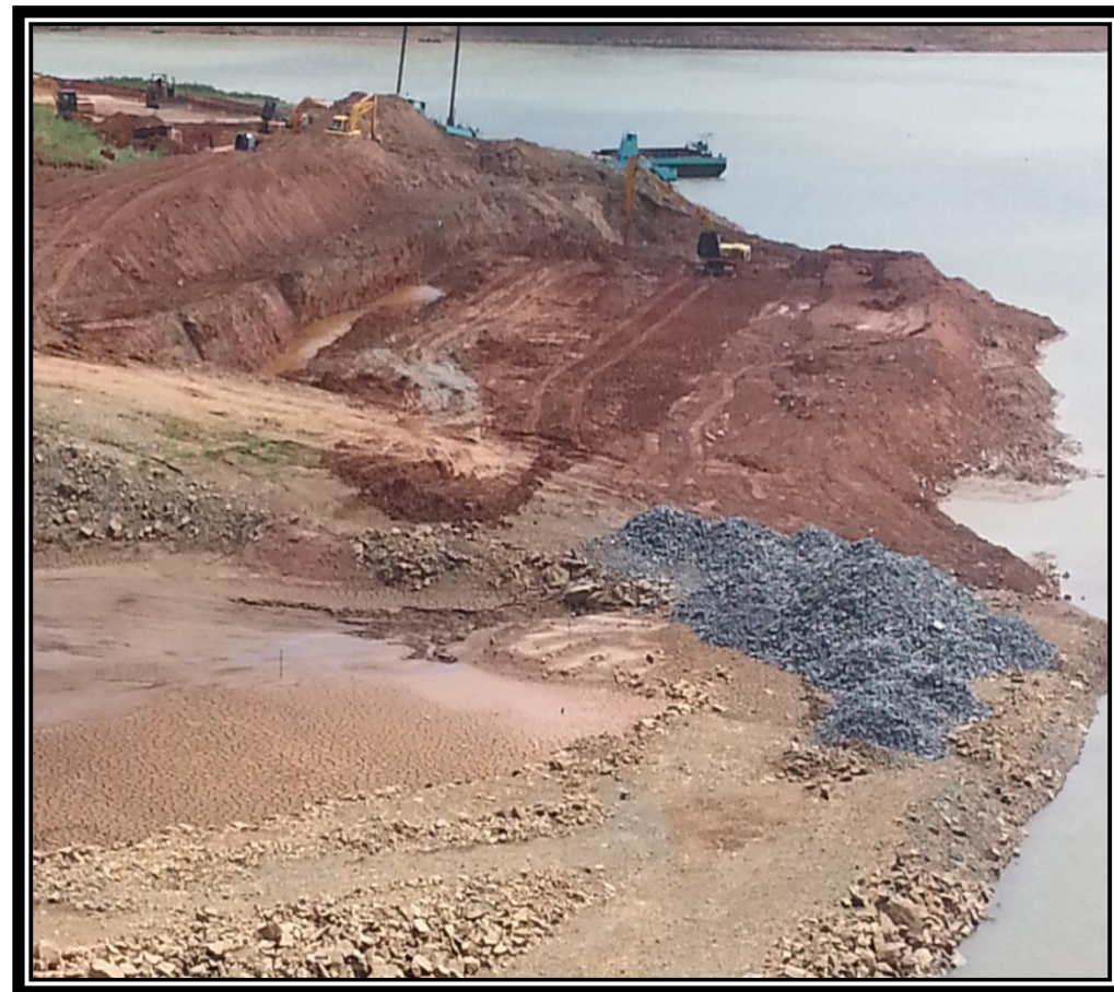
26/03/2014 - Escavação do canal de dissipação.
