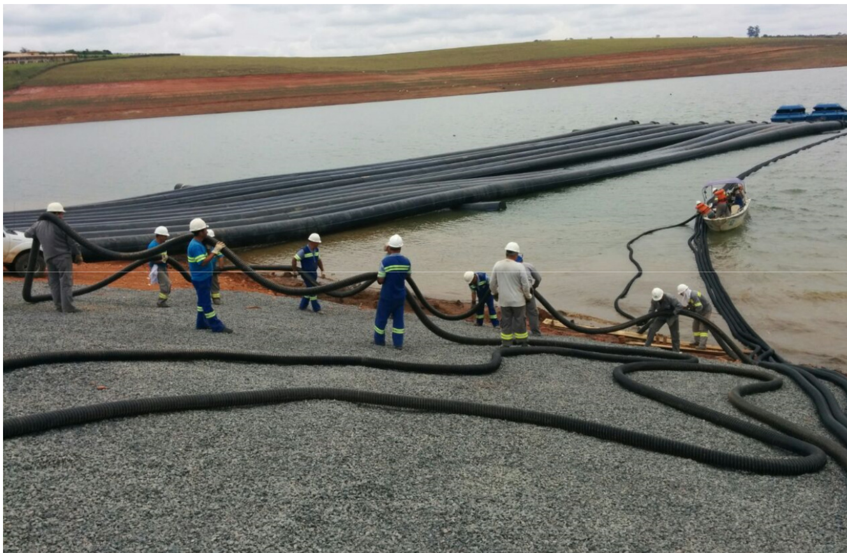
Mão de Obra Própria da Sabesp
