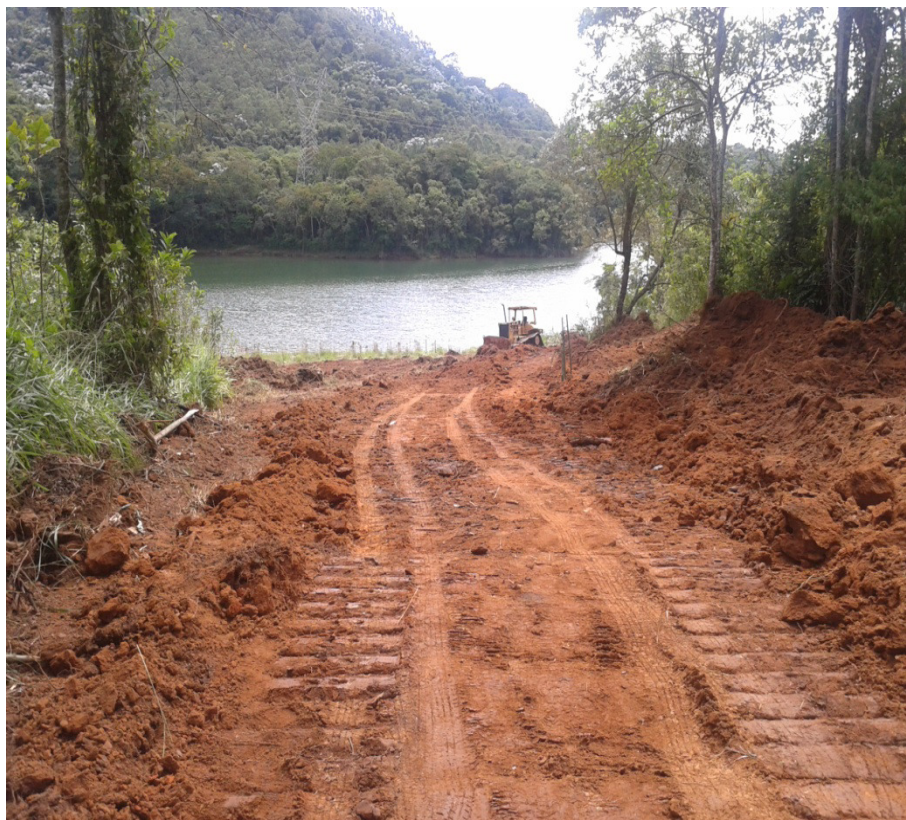
13/03/2014 - Início da estrada de acesso
