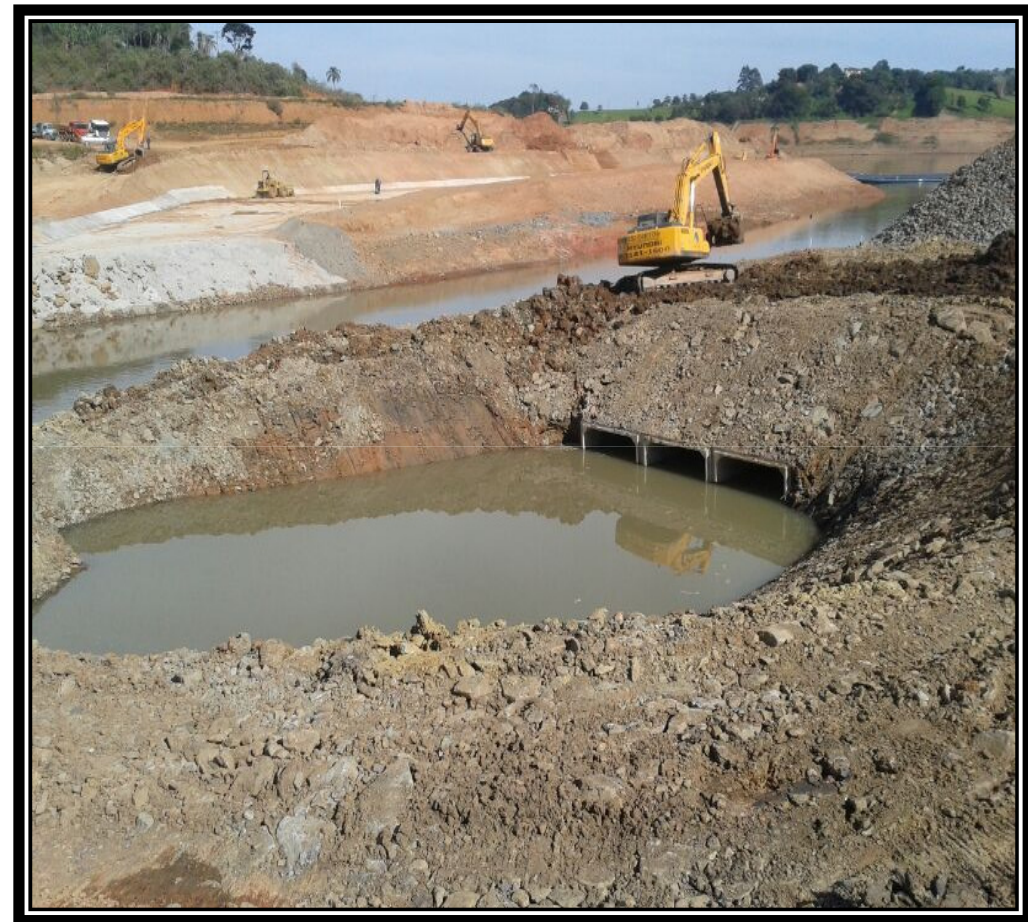
02/05/2014 – Vertedouro executado.
