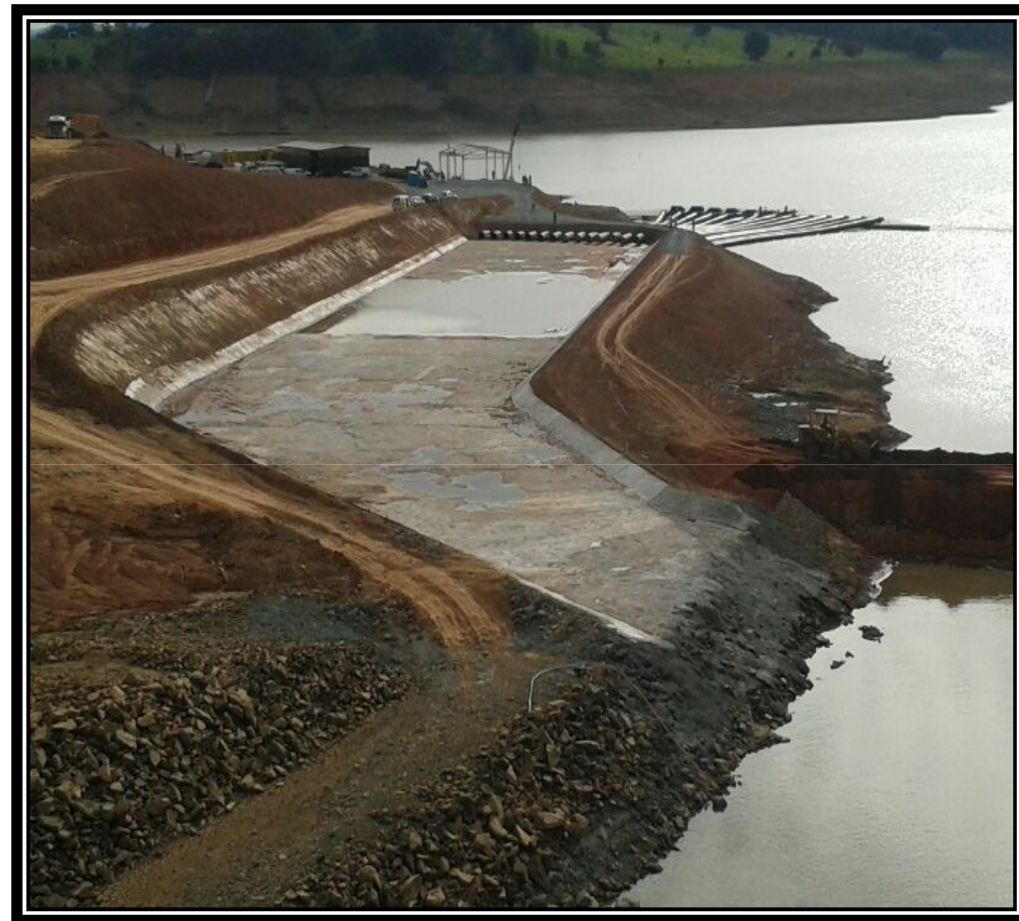
14/05/2014 - Canal de dissipação pronto.
