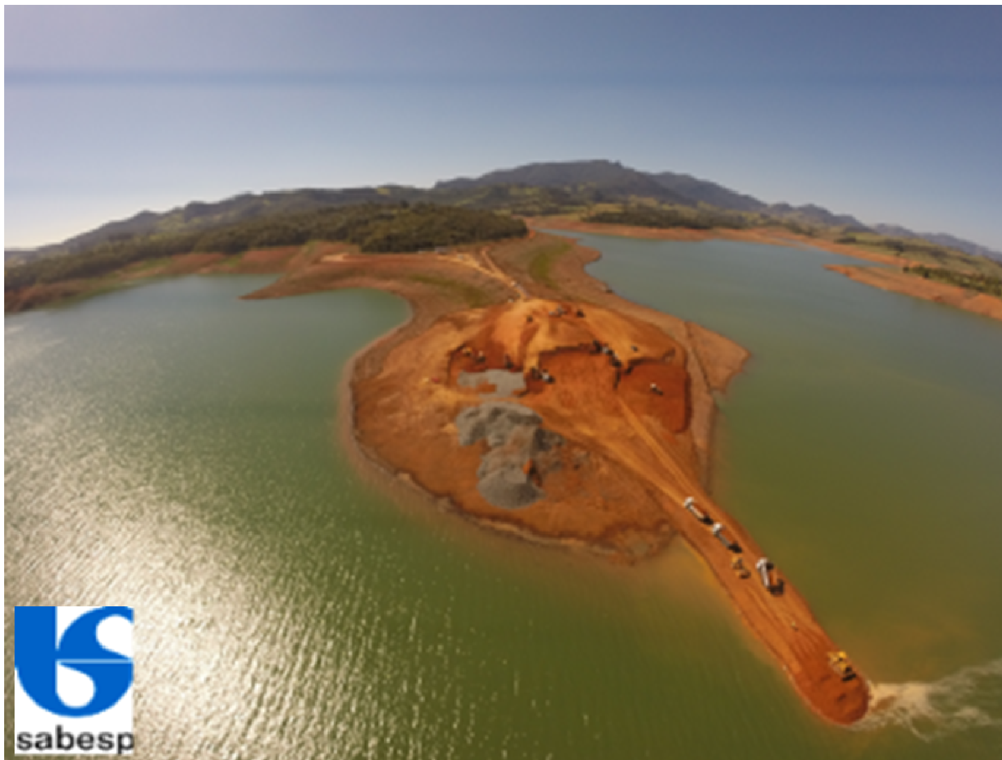
Pátio de mistura de argila/brita ao lado da barragem em execução
