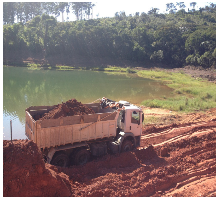
17/03/2014 - Início da escavação do Canal
