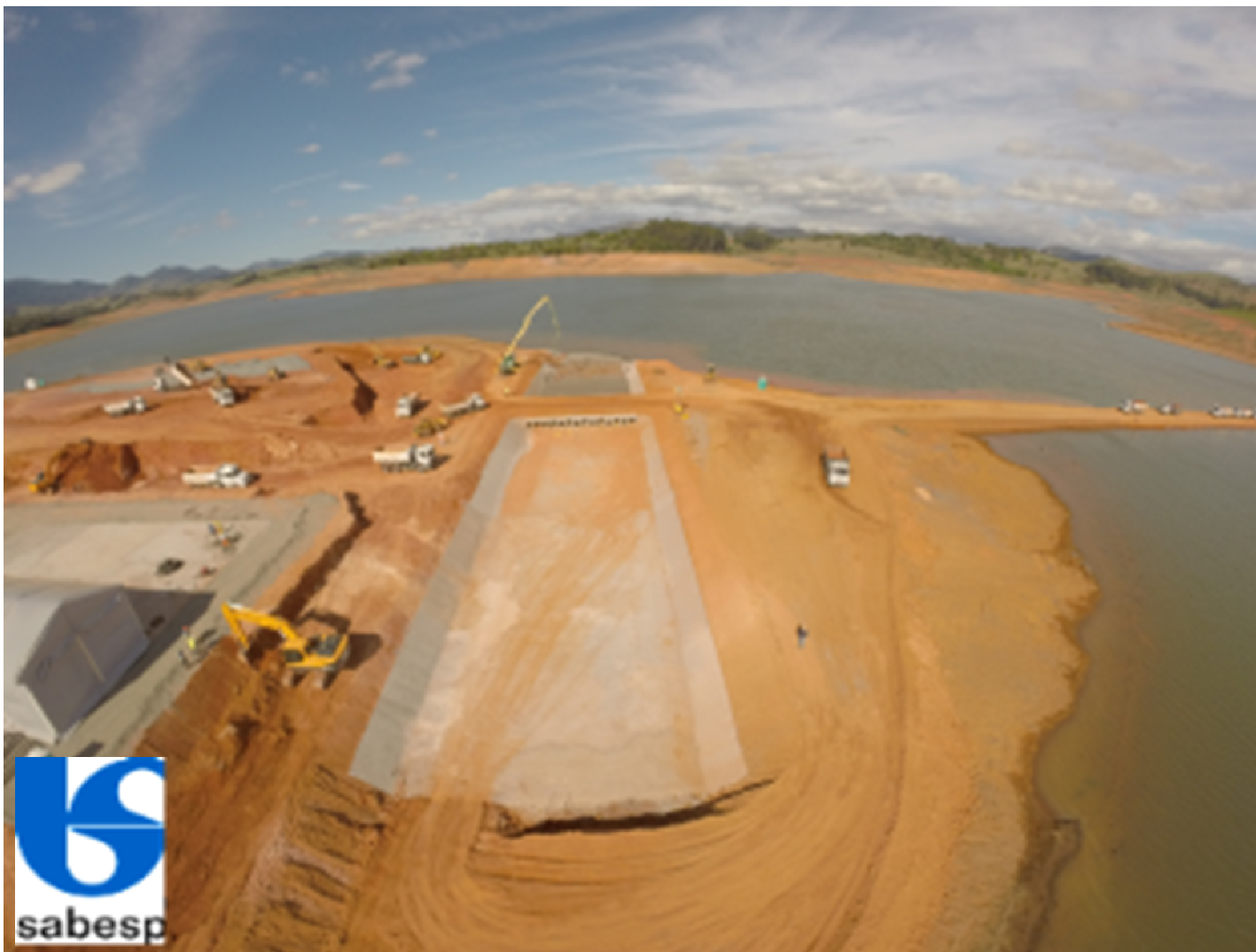
Canal de transferência e passagem para acesso a barragem sobre tubos de concreto
