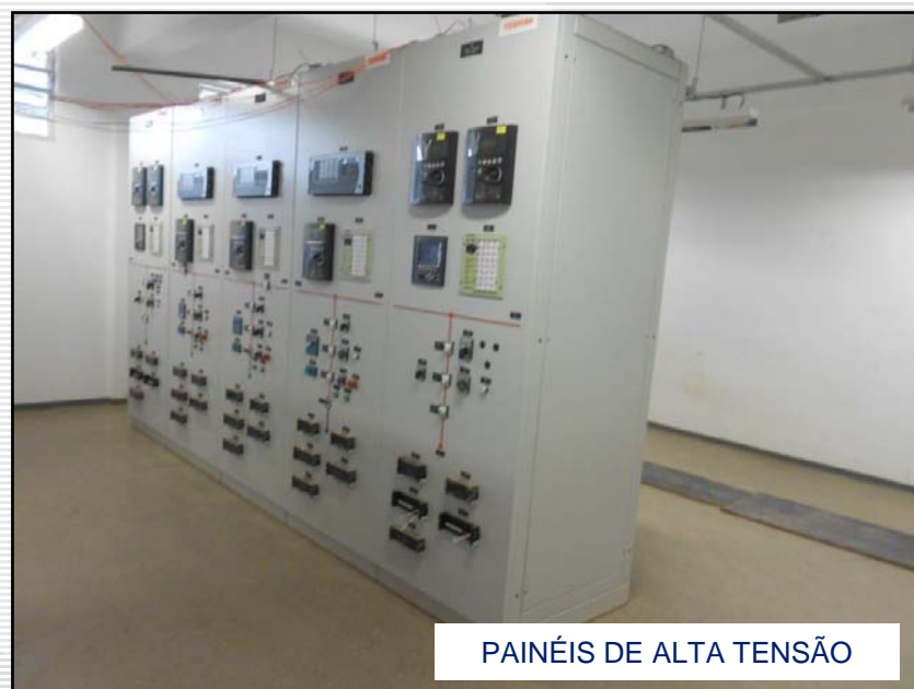
EDIFÍCIO DE ALTA TENSÃO - BARRAMENTO DE 22KV
