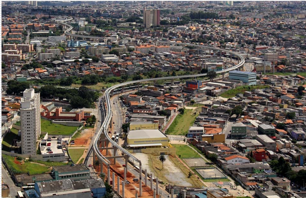
Elevado a Oeste da Estação São Mateus
