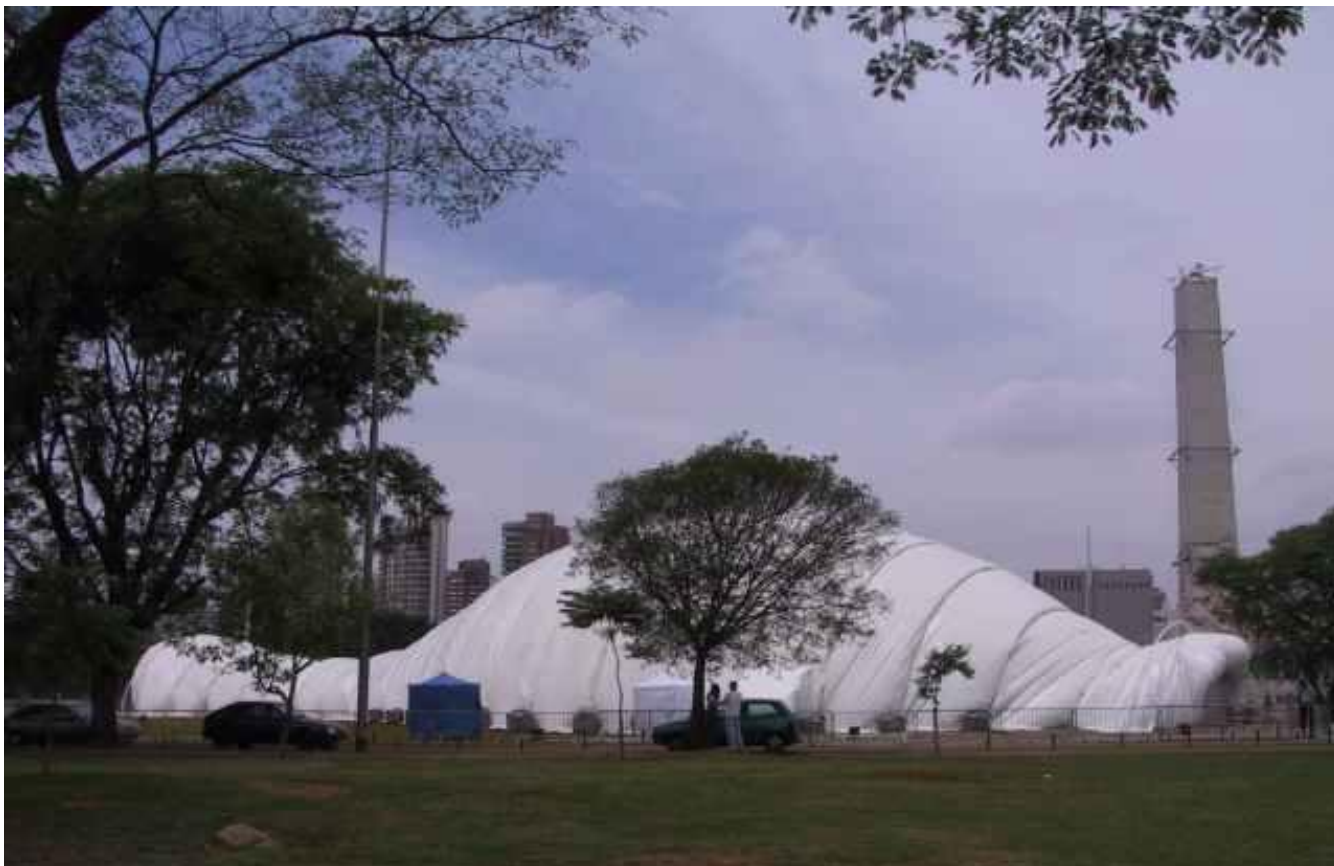
Pavilhão da Exposição Petrobrás - A Energia de Um Sonho Arq. José Wagner Garcia
