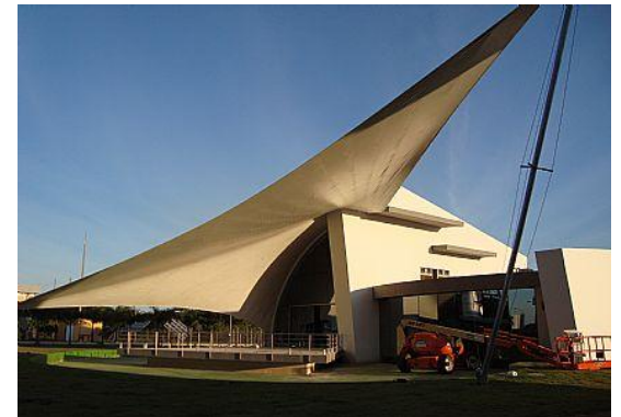
Usina Termo-elétrica Norte Macaé - RJ, 160m 2 (2007)
