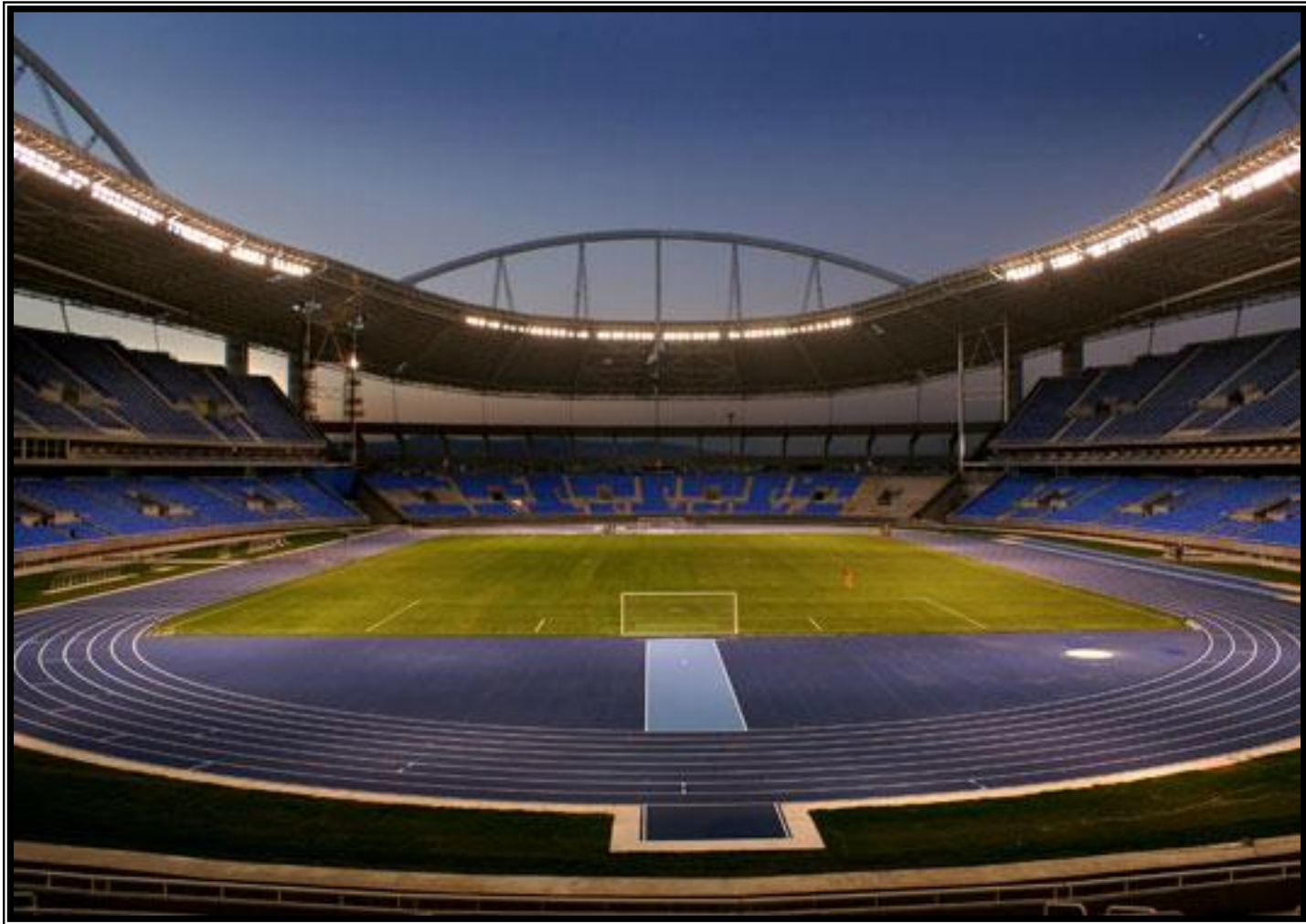
Arquitetura: CARLOS PORTO e GILSON RAMOS DOS SANTOS PROJETO ESTRUTURAL DA COBERTURA: FLAVIO D ALAMBERT
