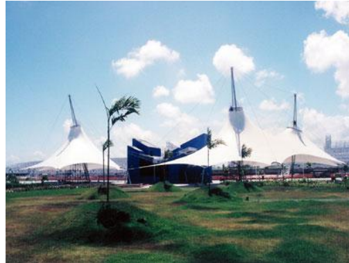
Garagem Aeroporto Internacional do Recife 1500m 2 (2001)
