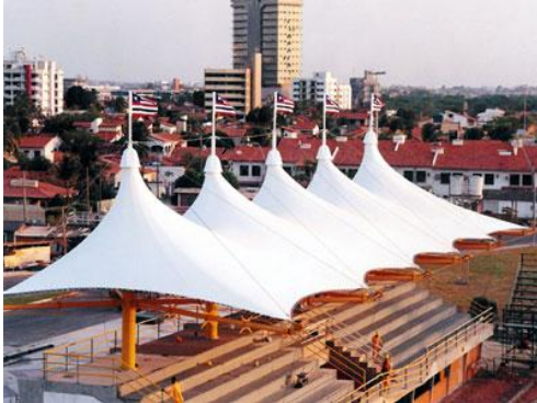
Arquibancada Beach Soccer São Luiz, MA 750m 2 (2001) Arq. Carlos Campello
